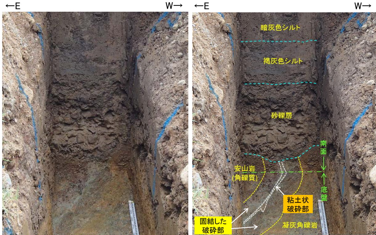
南面 拡大写真
