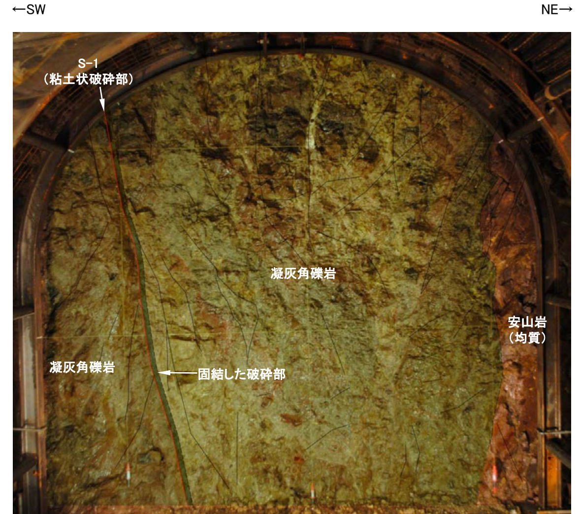
No.30切羽写真(割れ目等を加筆)
