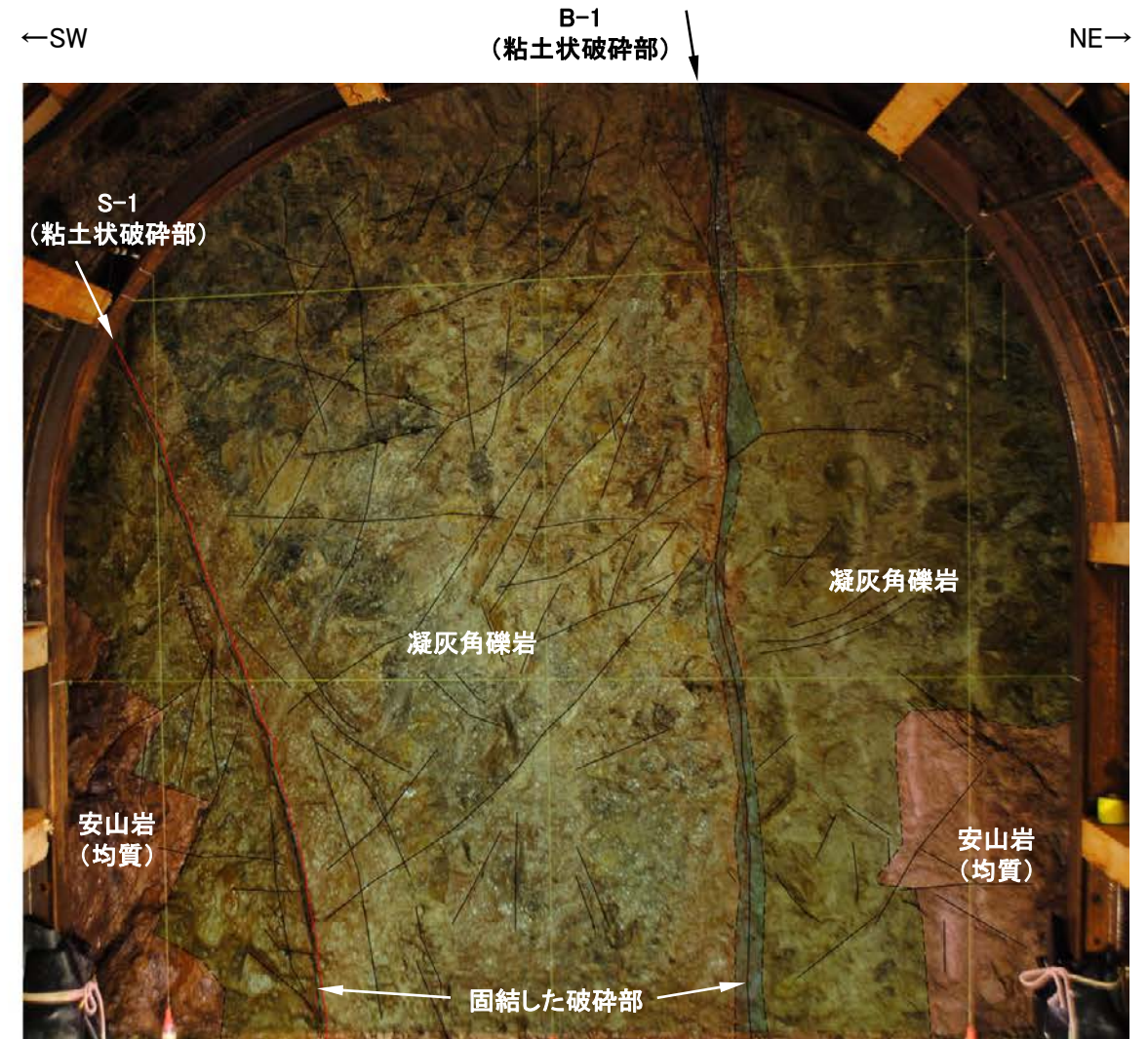
No.11切羽写真(割れ目等を加筆)
