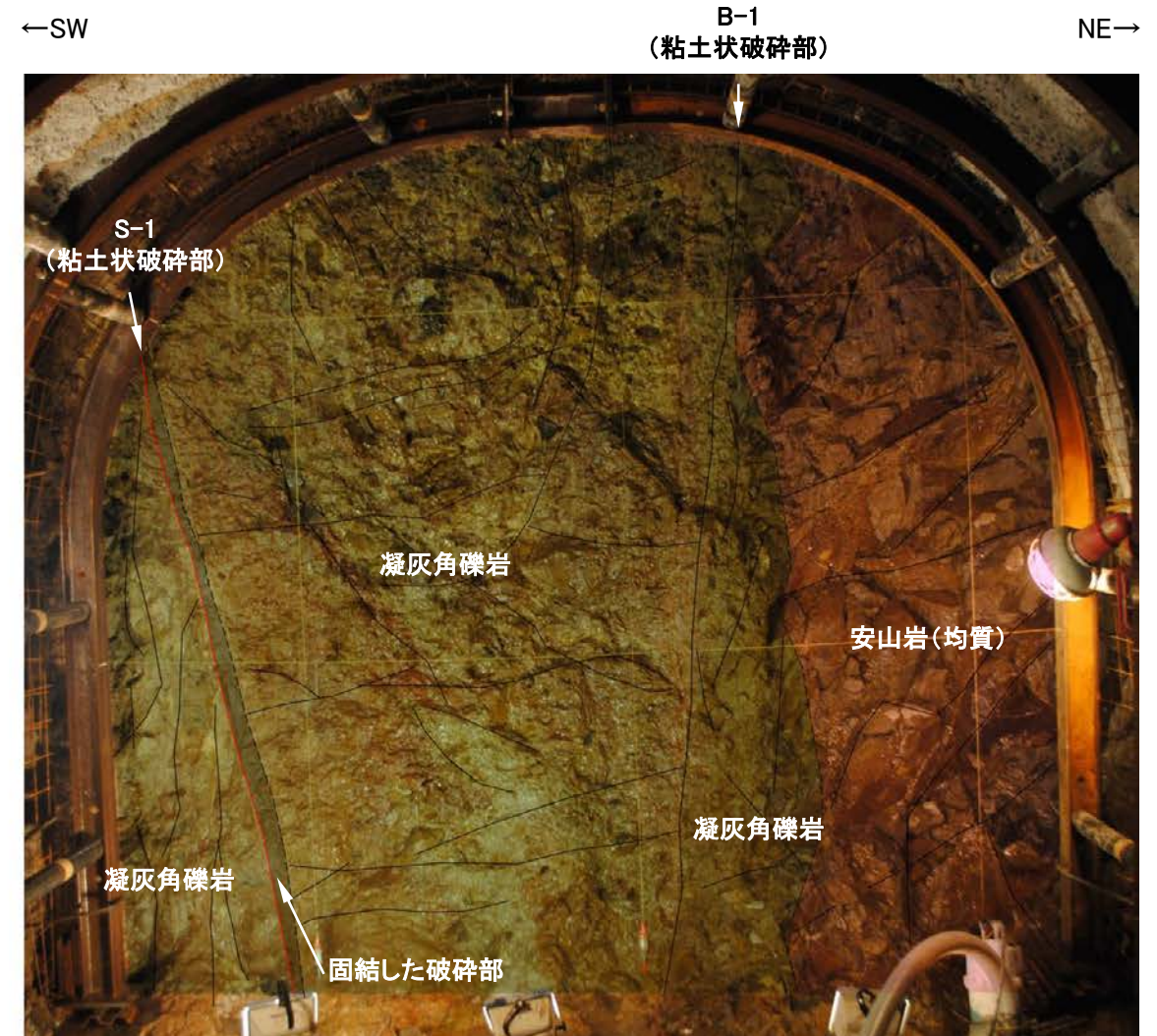
No.26切羽写真(割れ目等を加筆)
