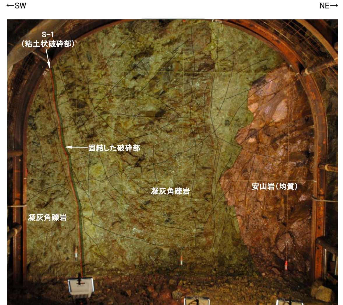
No.28切羽写真(割れ目等を加筆)
