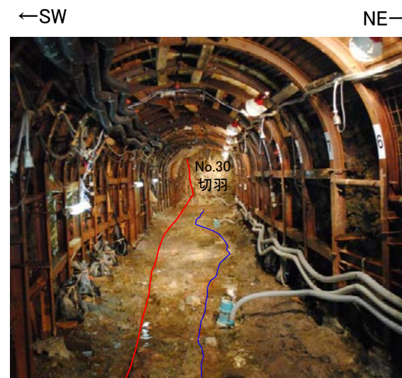
横坑の状況写真 (立坑側より、2013年撮影)
