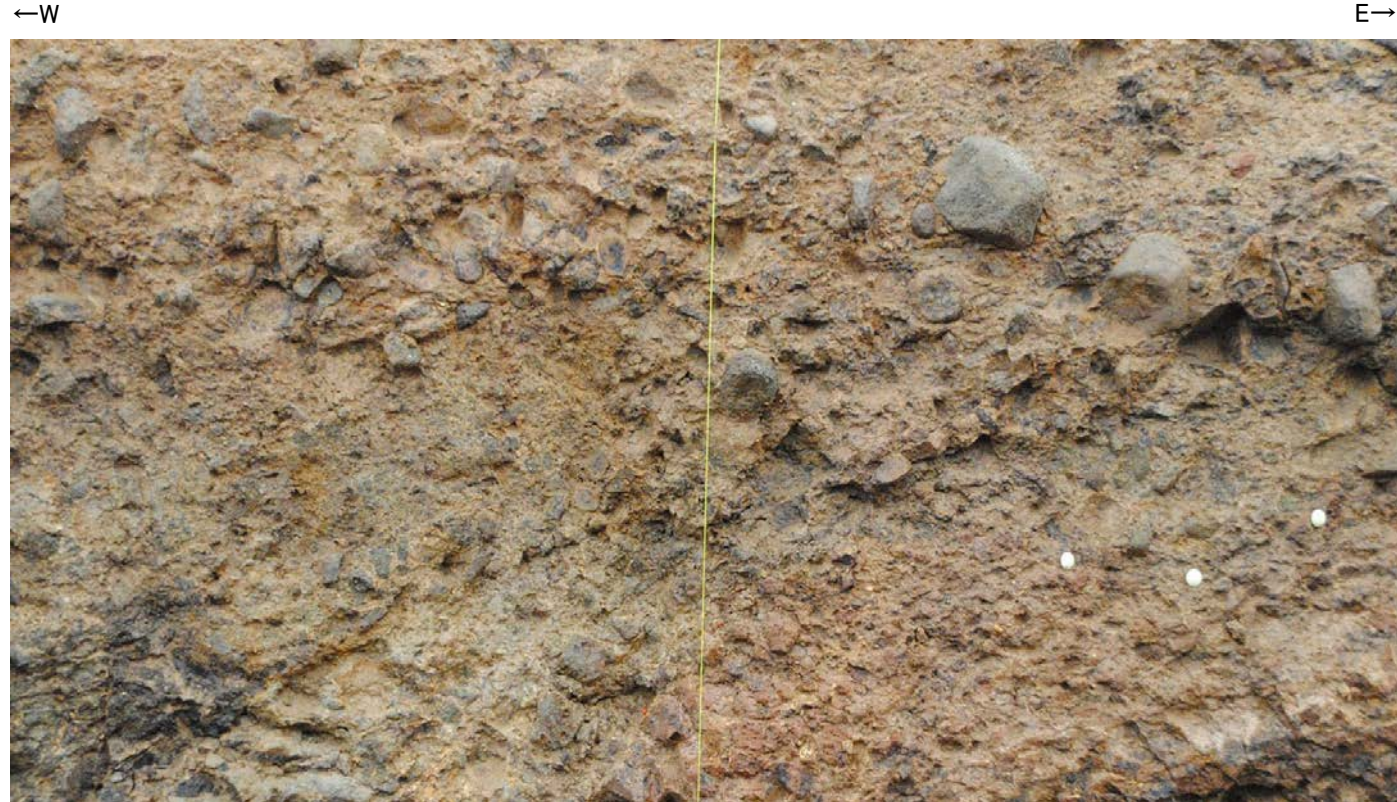
北面調査箇所 拡大写真
