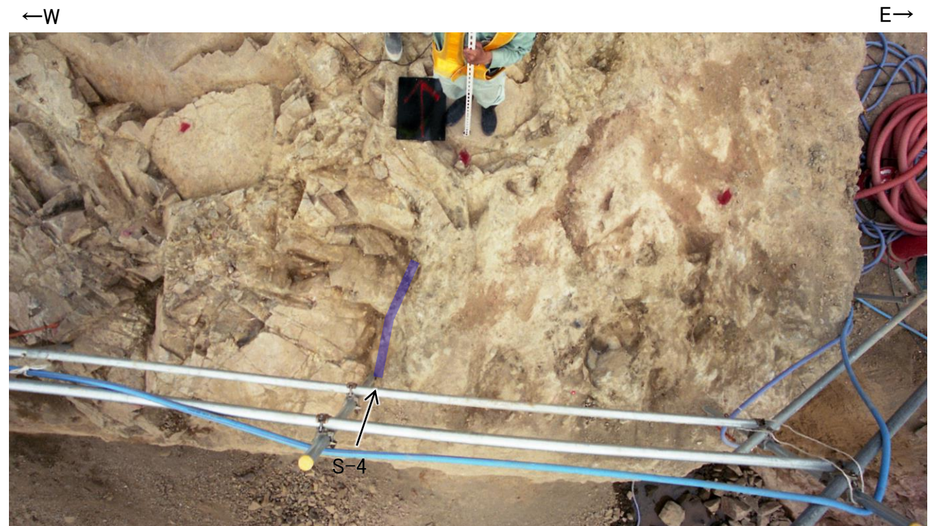
写真② 2号機地下式軽油タンク(DBA)連絡ダクト底盤 S-4端部(S-4を加筆)
