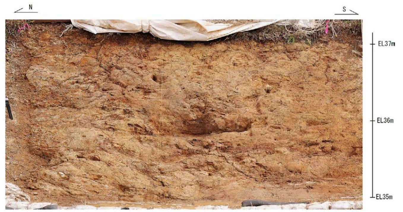
35m盤法面 写真
