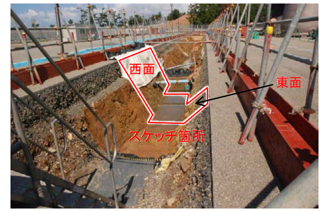
トレンチ全景写真
