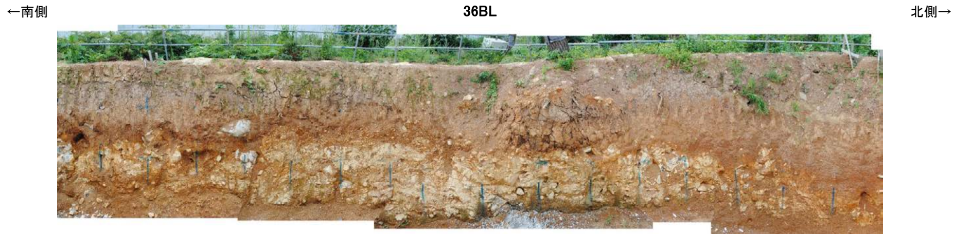
防潮堤設置時写真[36BL]
