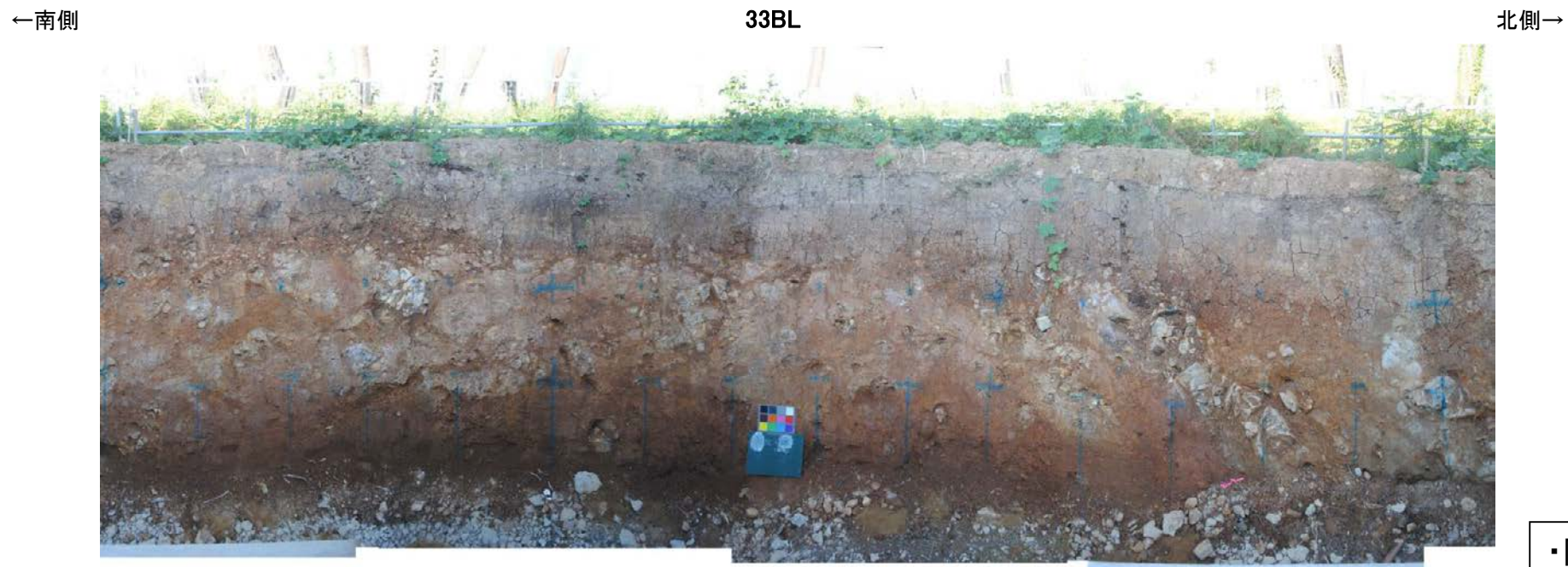
防潮堤設置時写真[33BL]
