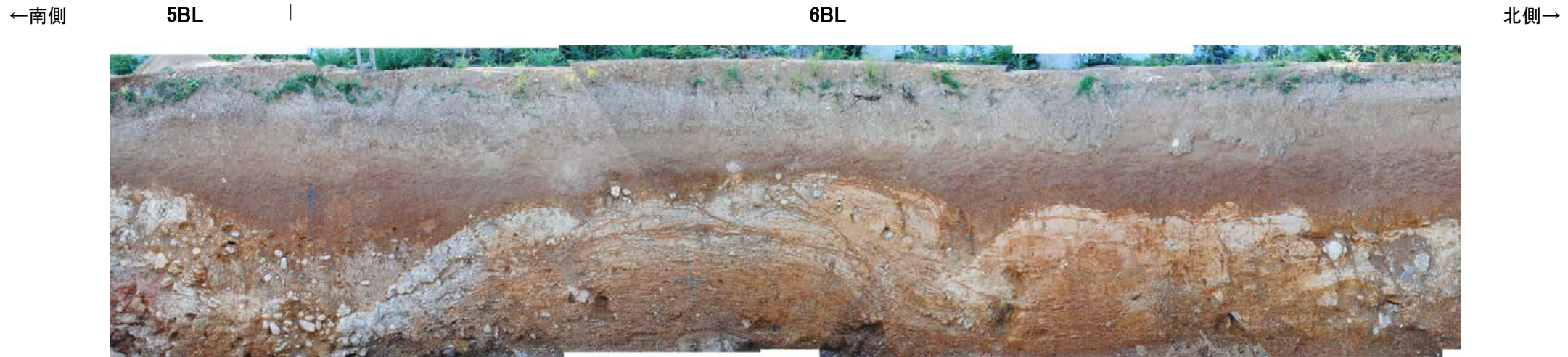
防潮堤設置時写真[5BL, 6BL]②
