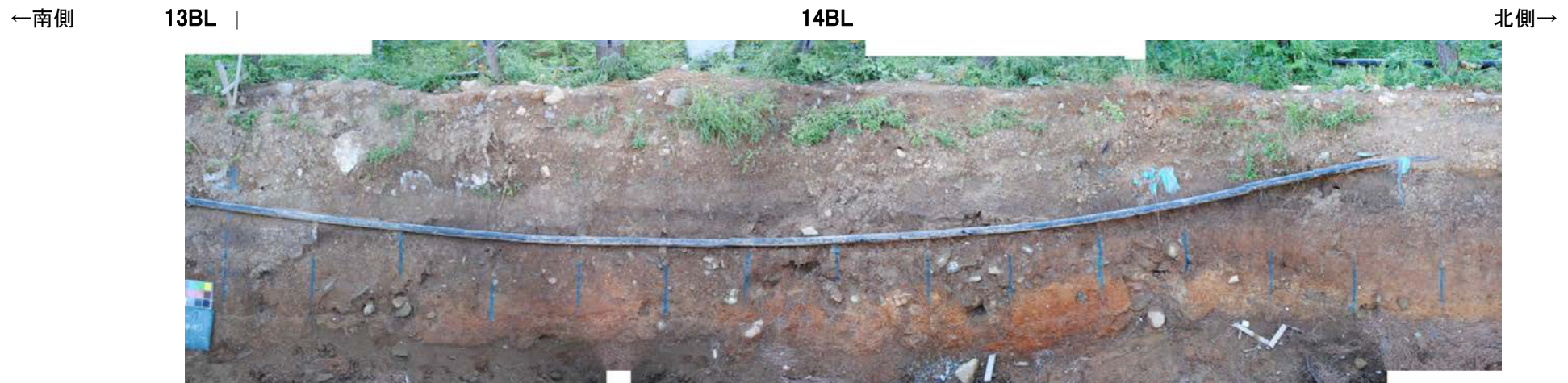
防潮堤設置時写真[13BL, 14BL]②
