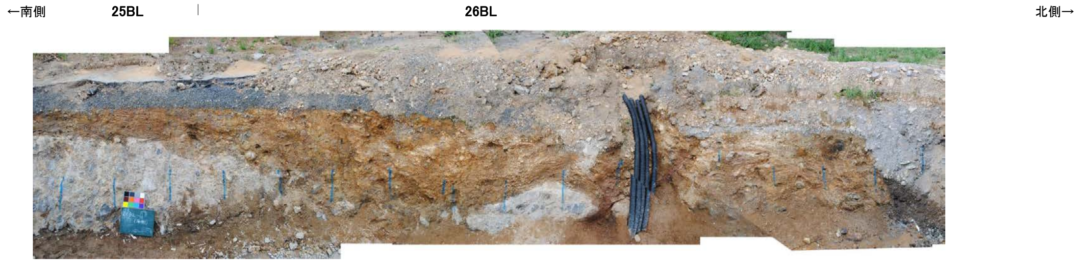
防潮堤設置時写真[25BL, 26BL]②
