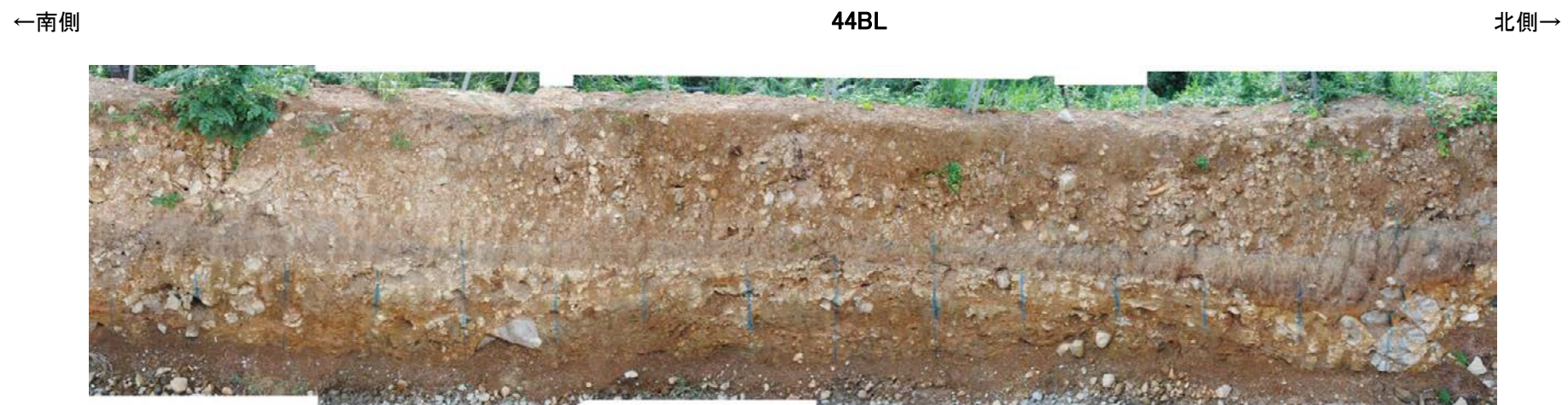
防潮堤設置時写真[44BL]
