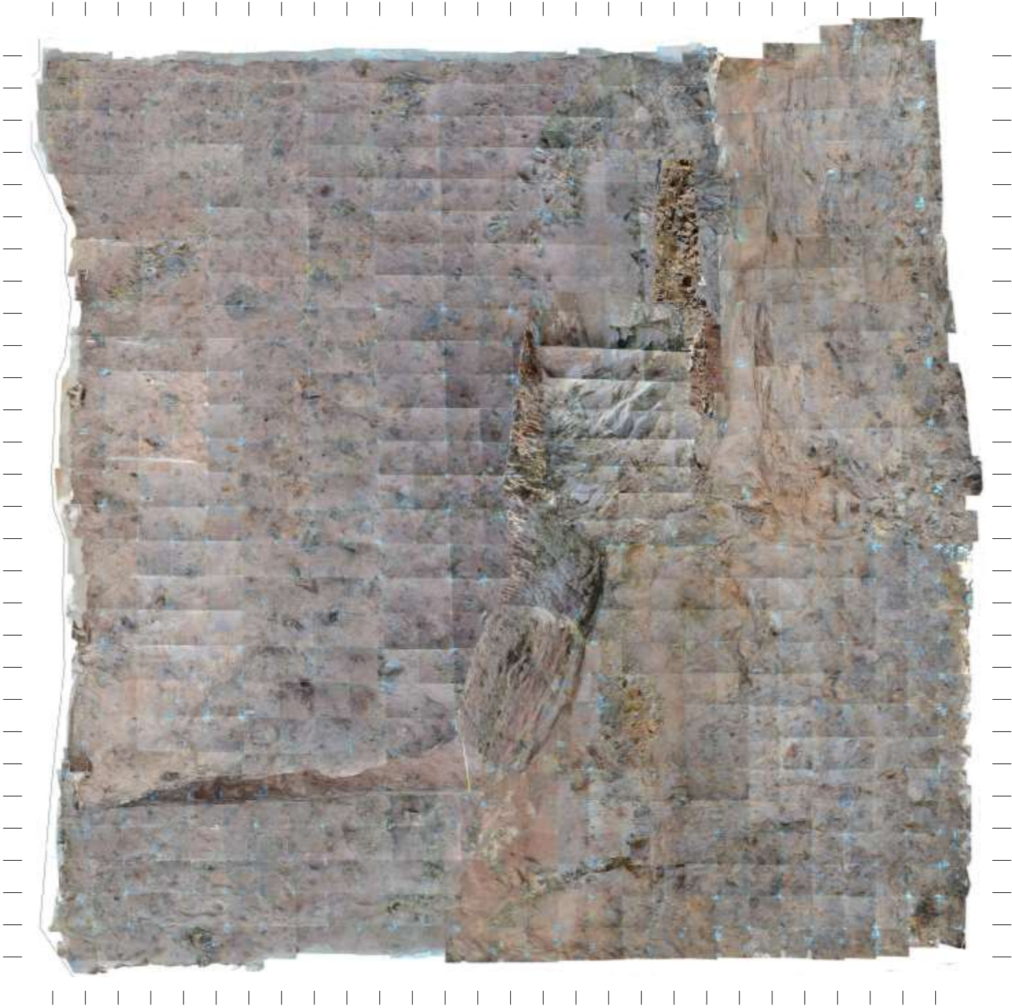
代替所内電気設備建屋 基礎地盤写真
