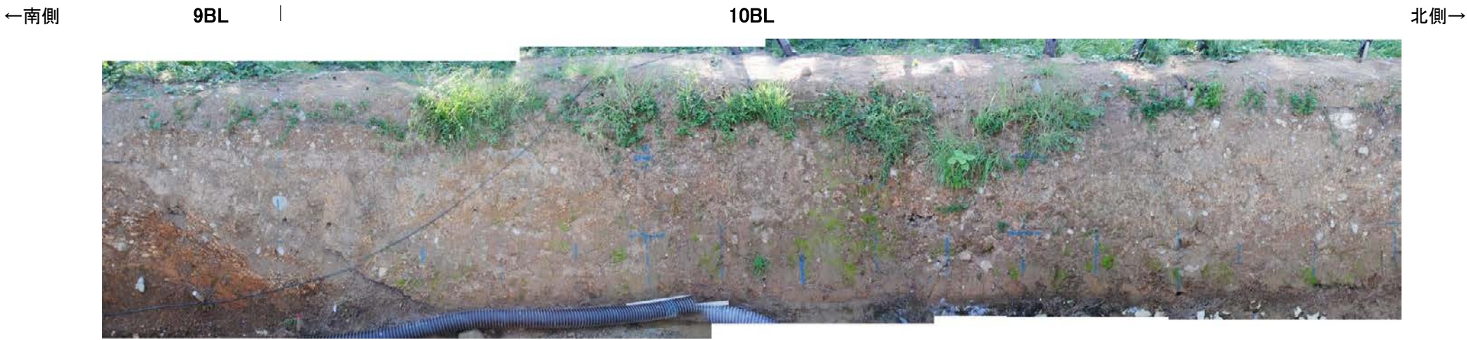
防潮堤設置時写真[9BL, 10BL]②
