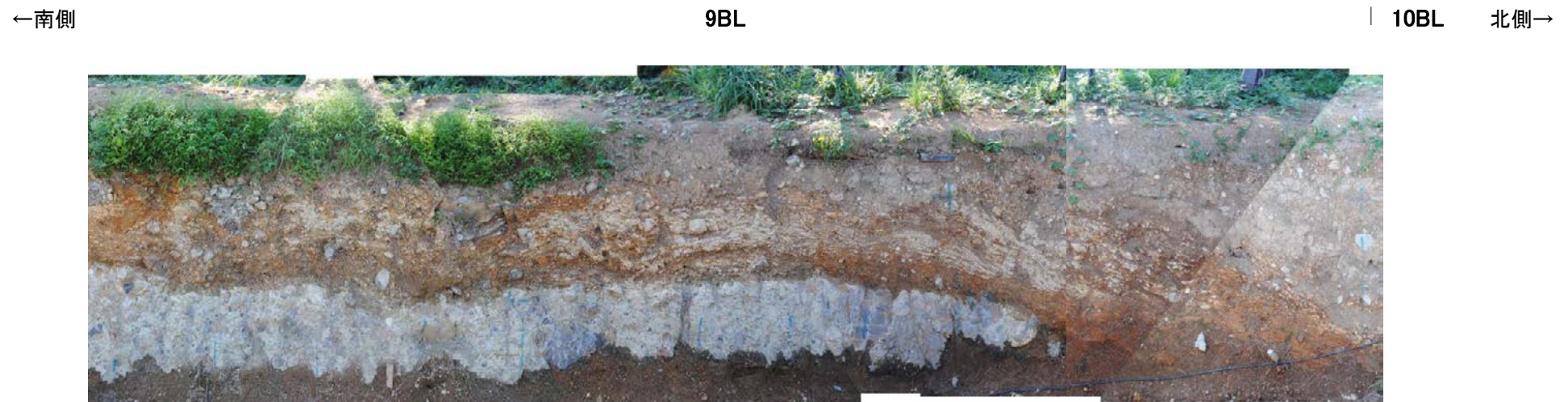
防潮堤設置時写真[9BL, 10BL]①
