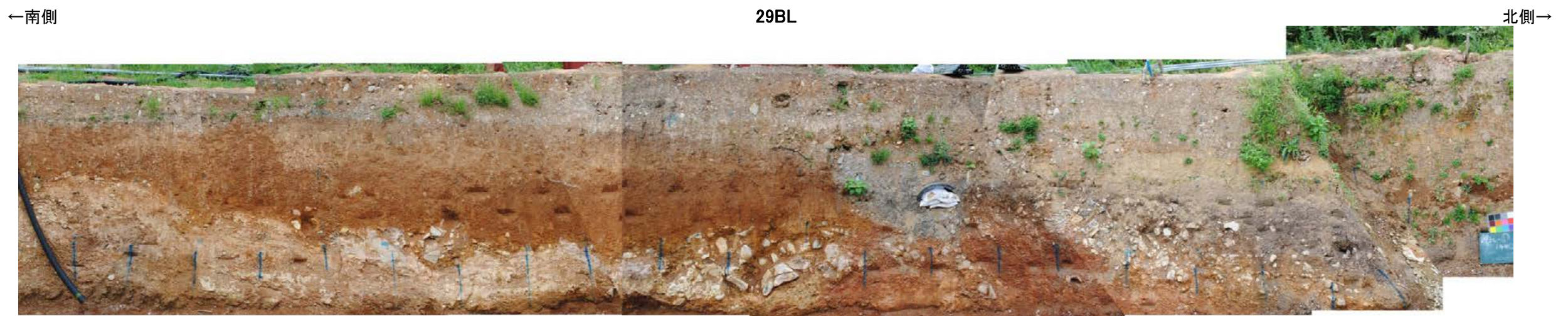
防潮堤設置時写真[29BL]
