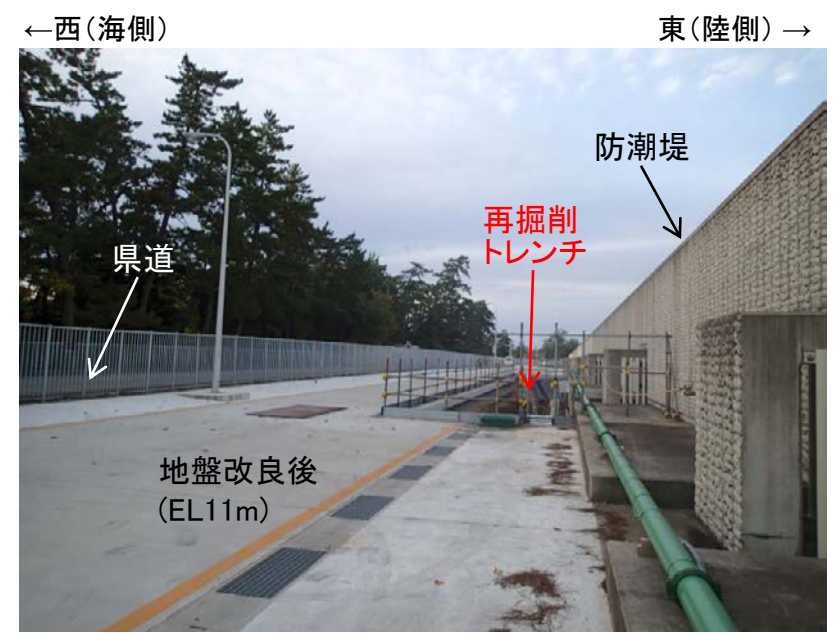
トレンチ箇所の全景写真 (現在の状況)
