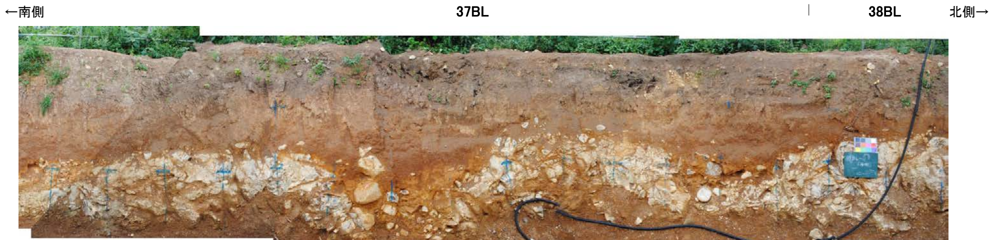
防潮堤設置時写真[37BL, 38BL]①
