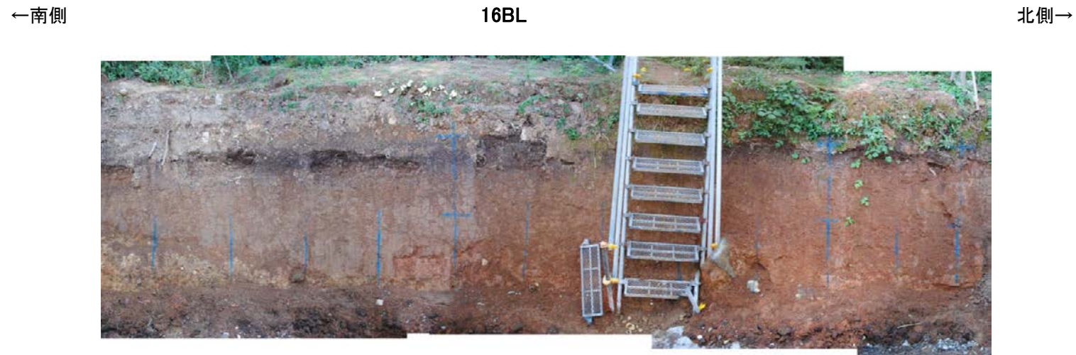
防潮堤設置時写真[16BL]
