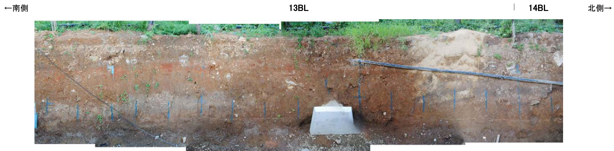
防潮堤設置時写真[13BL, 14BL]①
