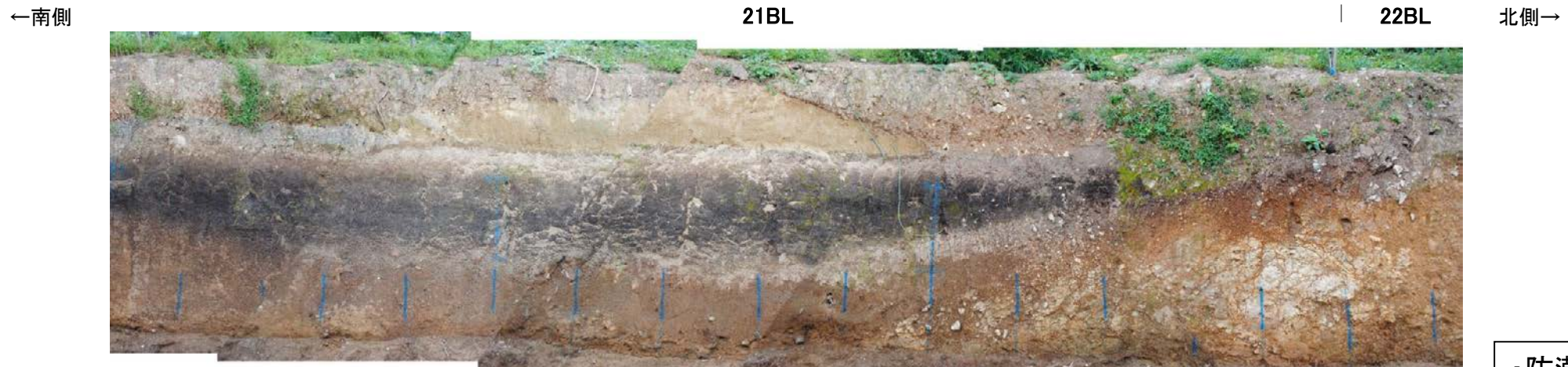
防潮堤設置時写真[21BL, 22BL]①
