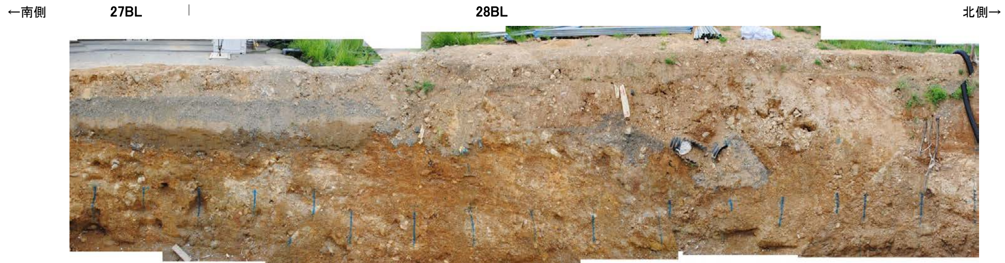
防潮堤設置時写真[27BL, 28BL]②
