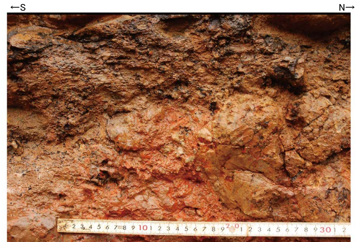
岩盤上面拡大写真(2022年4月撮影)
