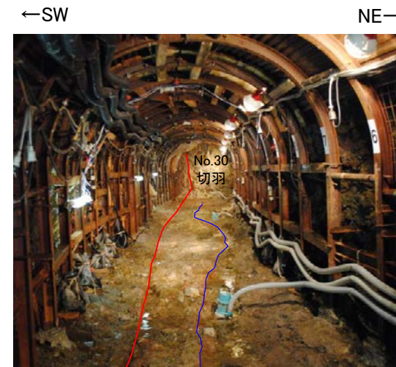
横坑の状況写真 (立坑側より, 2013年撮影)
