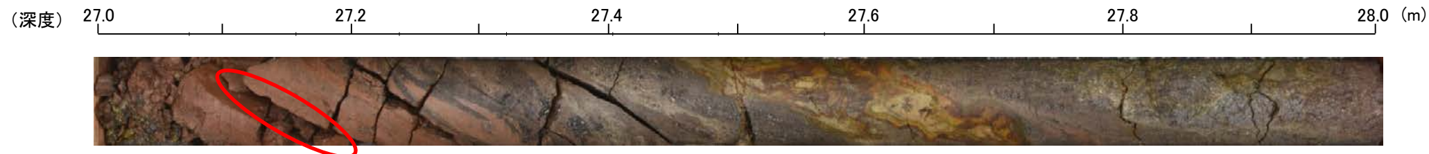
i. H- -1.2孔 深度27.15m付近
