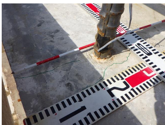
(a) 「浮き」除去前
