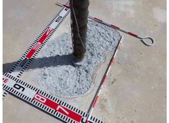
(b) 「浮き」 除去後
