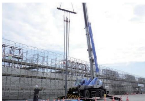
3. 新設部分の主筋建込み
