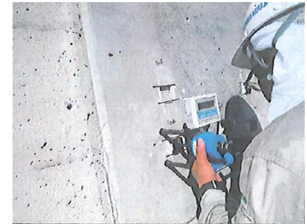
図6 付着強度試験実施状況
