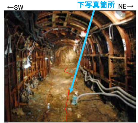
岩盤調査坑写真(全景写真)
