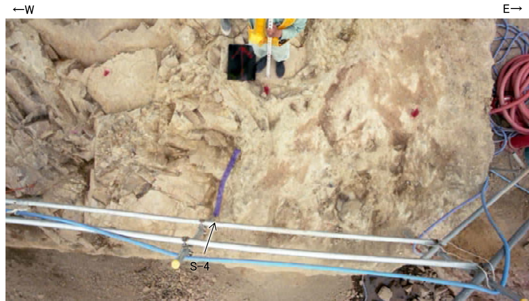
写真② 2号機地下式軽油タンク(DBA)連絡ダクト底盤 S-4端部(S-4を加筆)
