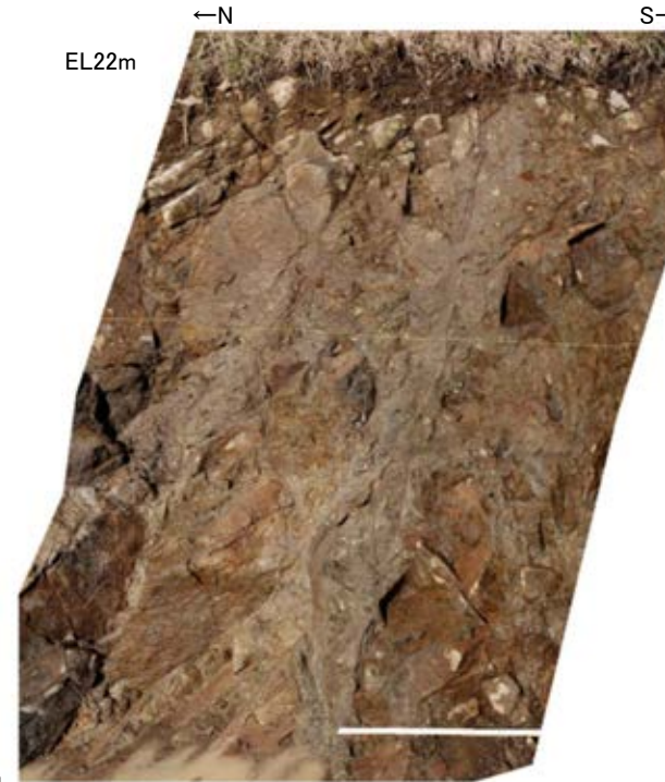
21m盤法面 写真
