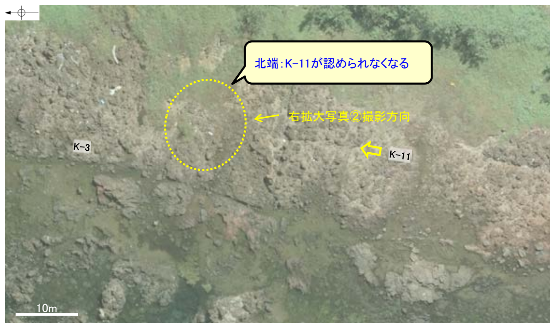
拡大写真① K-11の北方付近
