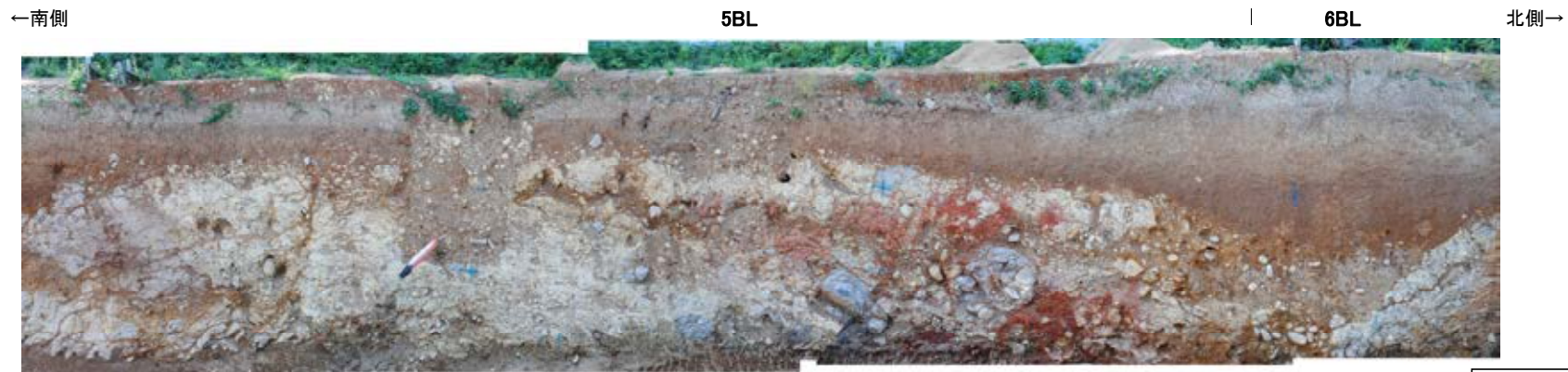
防潮堤設置時写真[5BL, 6BL]①
