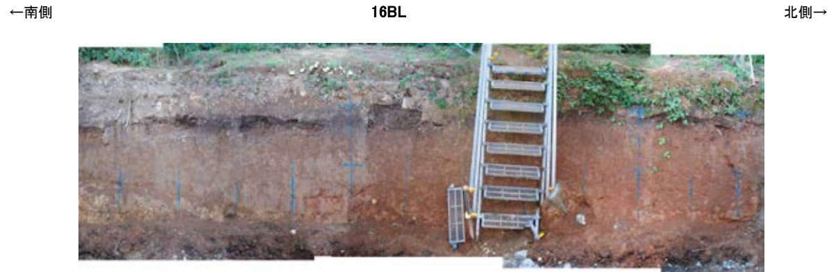
防潮堤設置時写真[16BL]
