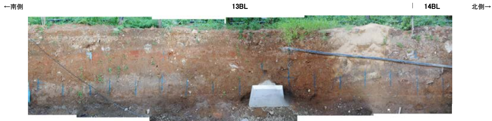
防潮堤設置時写真[13BL, 14BL]①
