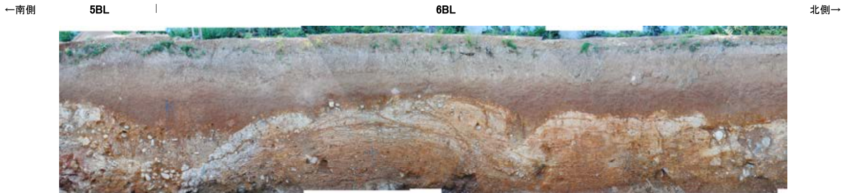
防潮堤設置時写真[5BL, 6BL]②
