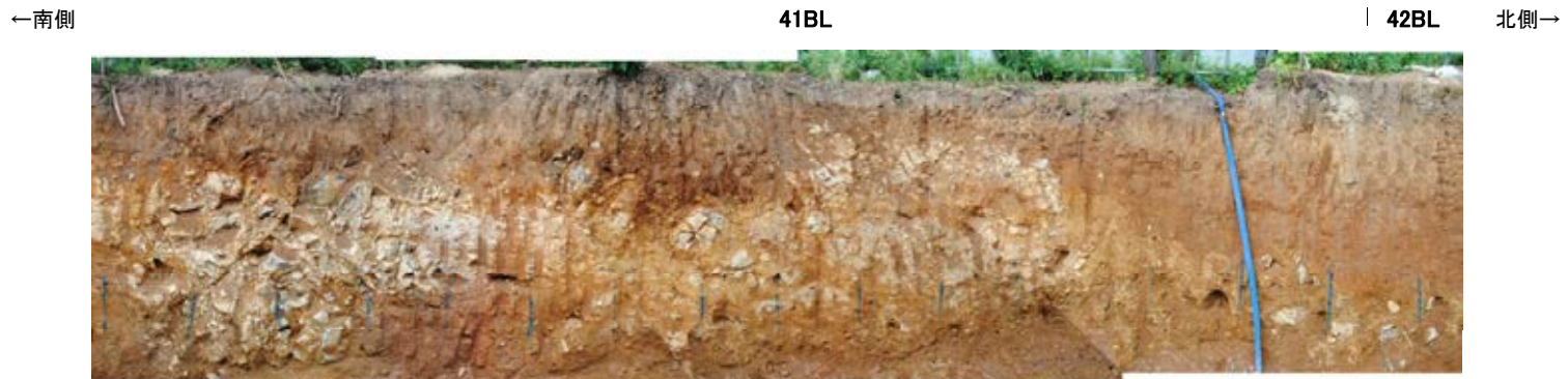
防潮堤設置時写真[41BL, 42BL]①
