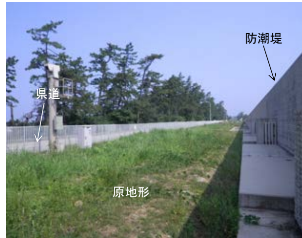
地盤改良工事前の写真 (原地形が残っている)
