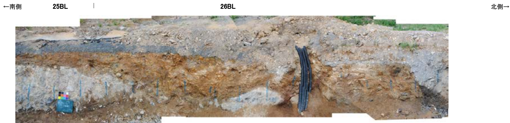
防潮堤設置時写真[25BL, 26BL]②
