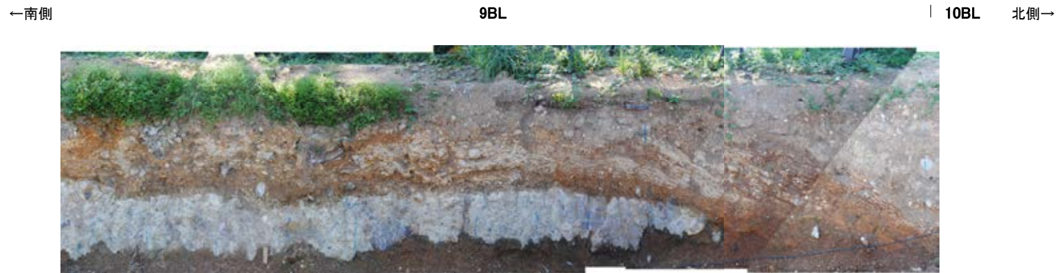
防潮堤設置時写真[9BL, 10BL]①
