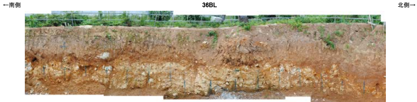
防潮堤設置時写真[36BL]
