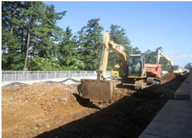
工事状況の写真 (表層部を掘削して地盤改良を行った)
