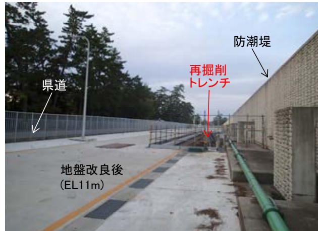
トレンチ箇所の全景写真 (現在の状況)
