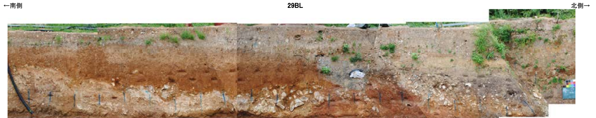
防潮堤設置時写真[29BL]
