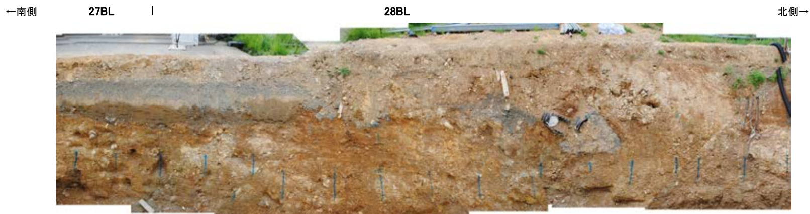
防潮堤設置時写真[27BL, 28BL]②
