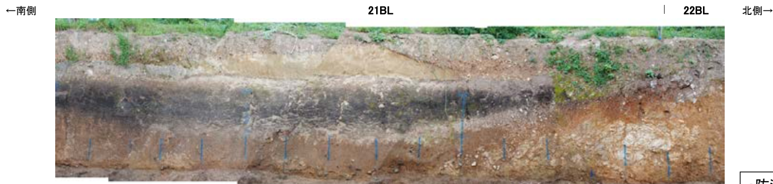
防潮堤設置時写真[21BL, 22BL]①
