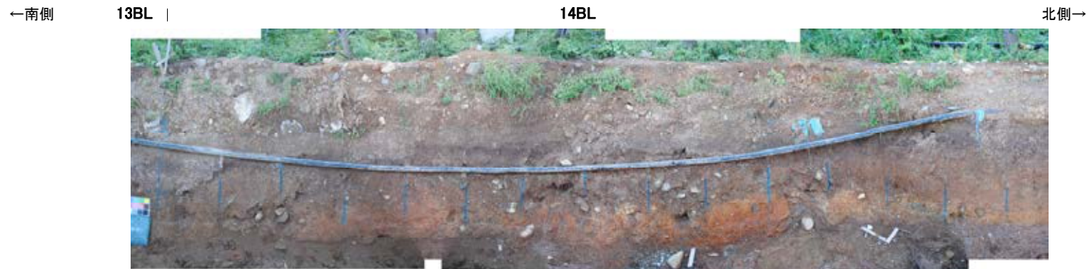
防潮堤設置時写真[13BL, 14BL]②
