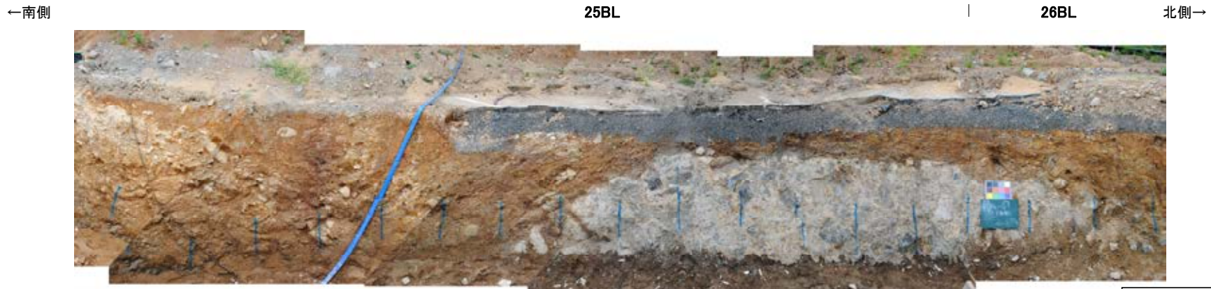
防潮堤設置時写真[25BL, 26BL]①
