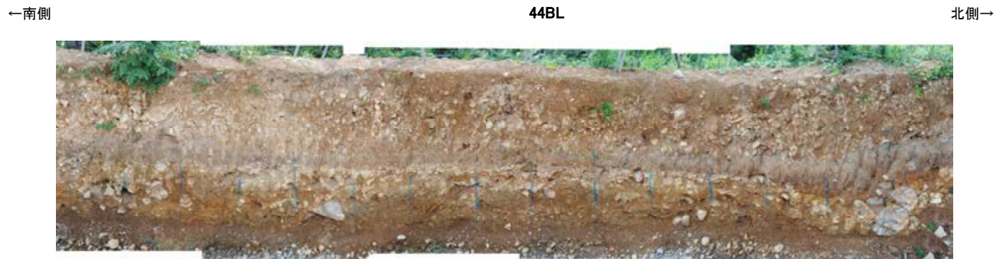
防潮堤設置時写真[44BL]
