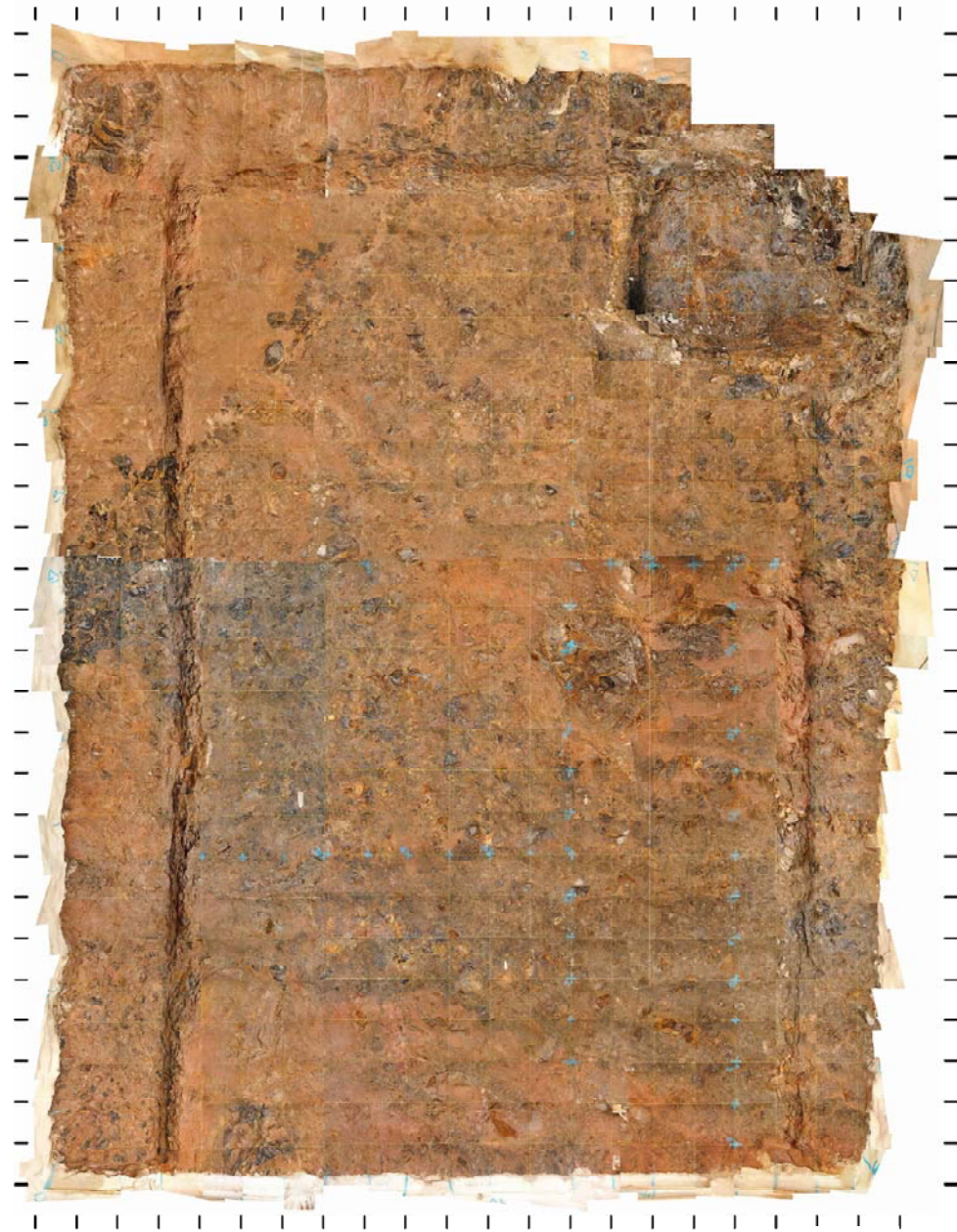
フィルタ付ベント装置建屋 基礎地盤写真
