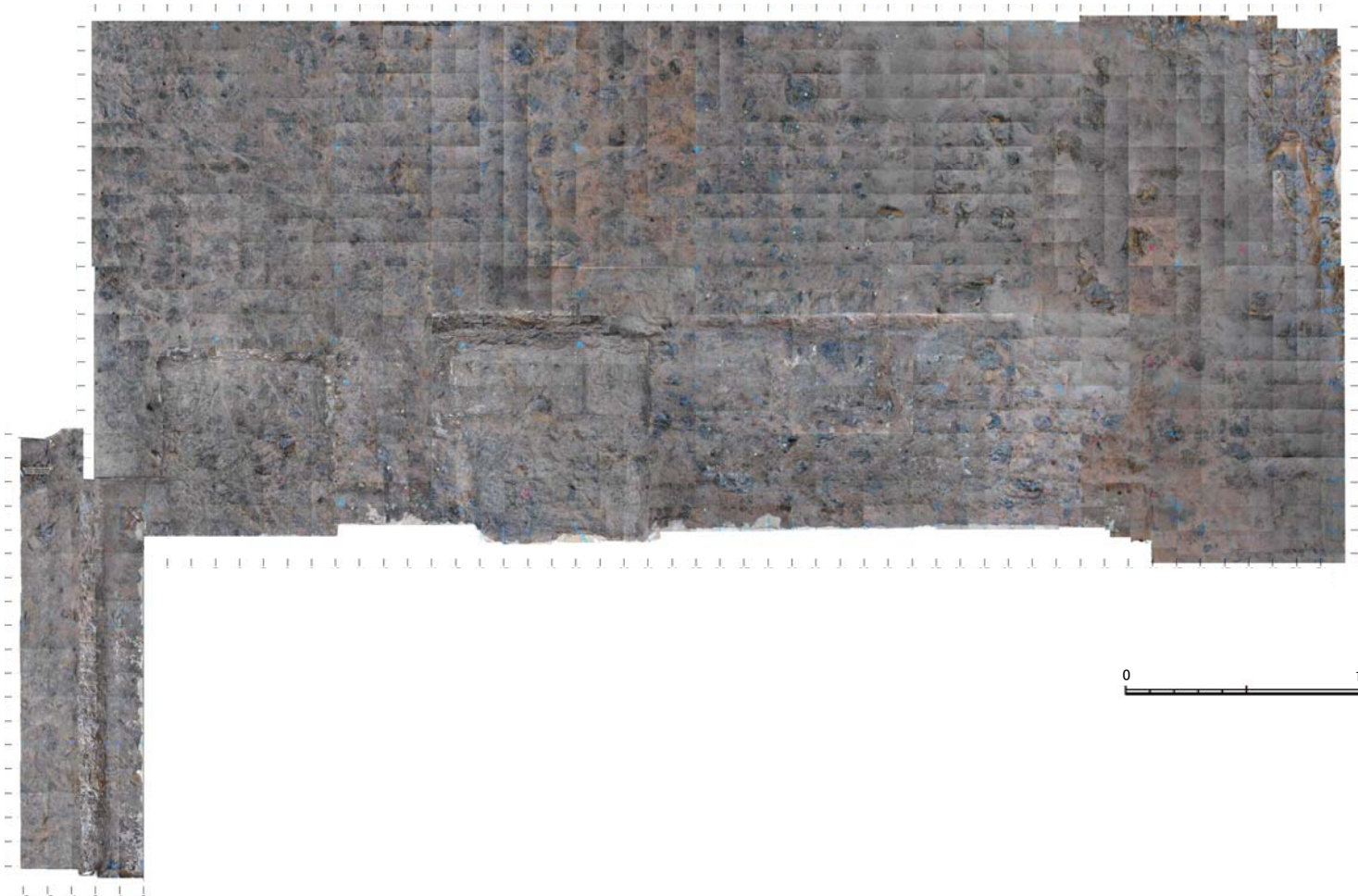
緊急時対策棟(増築棟) 基礎地盤写真
