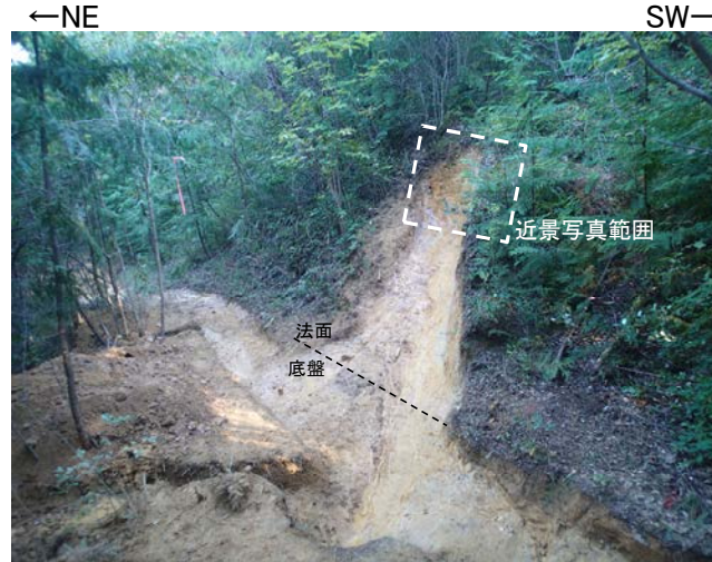
遠景写真(2013年撮影)
