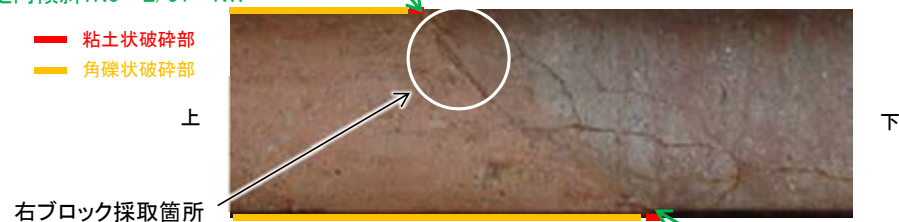
ボーリングコア写真(F-8.5' 孔)
