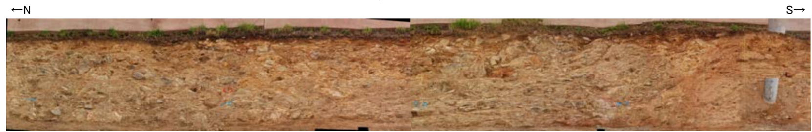
写真(35m盤法面)
