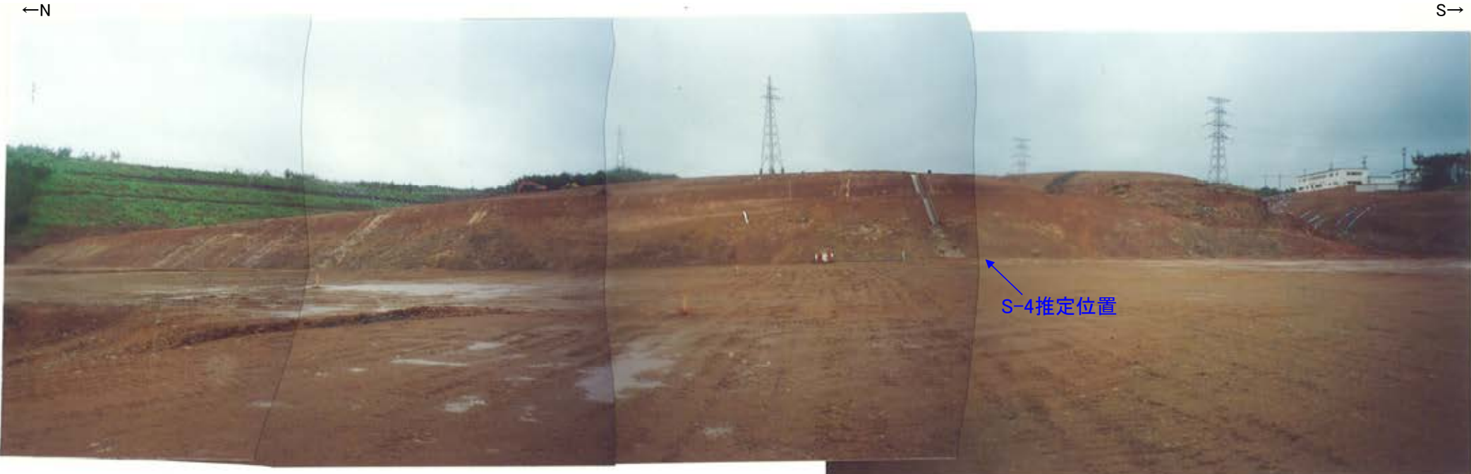
写真(2号機建設時)
