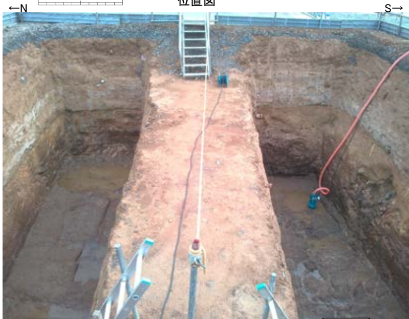
トレンチ状況写真(西側から撮影)
