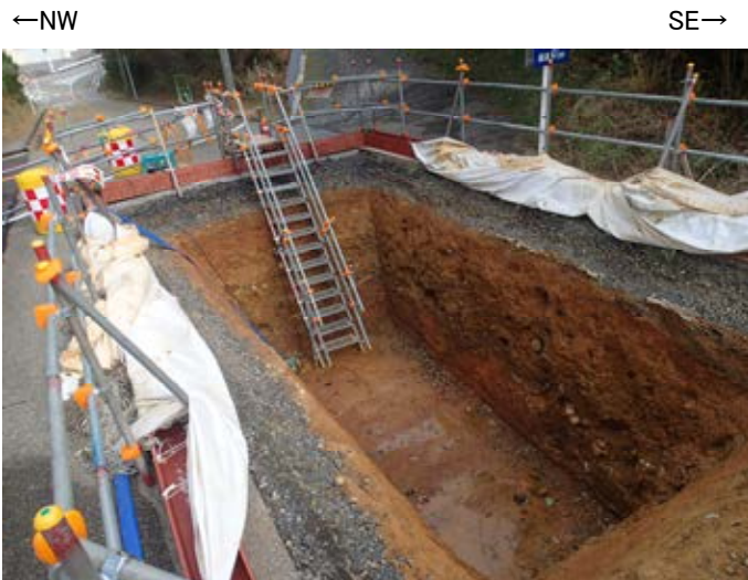
トレンチ状況写真(南西側から撮影)
