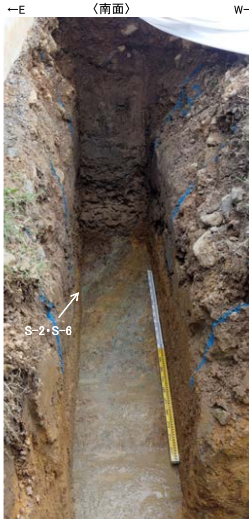
写真(事務本館前トレンチ)
