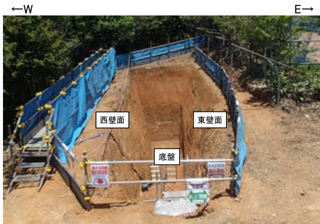
トレンチ状況写真(南側から撮影)
