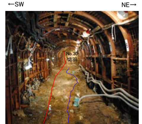
横坑の状況写真 (立坑側より, 2013年撮影)
