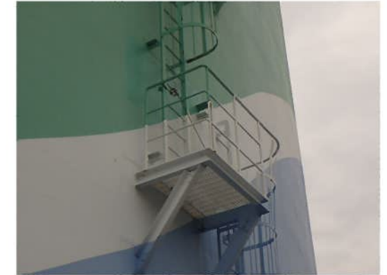
原子炉格納施設等 外部遮蔽壁（1号炉）
