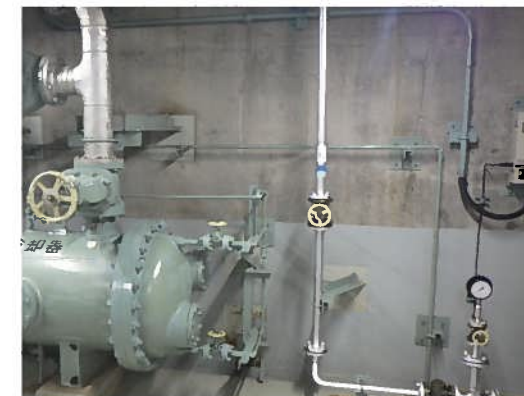
原子炉補助建屋 内壁及び床 (2号炉)
