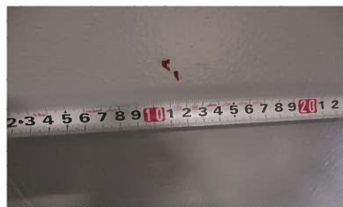
フロー②と判断した塗膜の劣化
