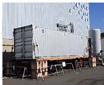
建屋外にある 遠隔操作用コンテナハウス
