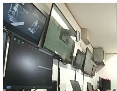
コンテナハウス内
