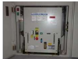
原子炉トリップ遮断器
