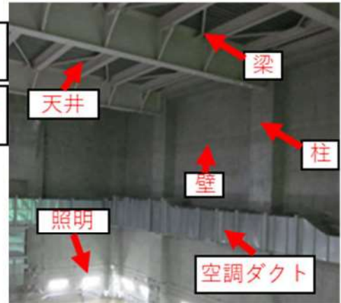
②使用済燃料ピット上部
