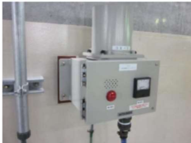
図2 機器のボルトによる壁面固定
