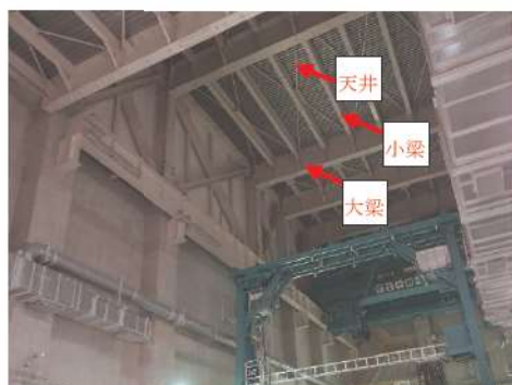
図 5.2.2 燃料取扱棟の屋根
