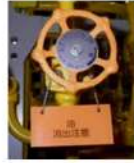
油類に係る弁 弁の識別
