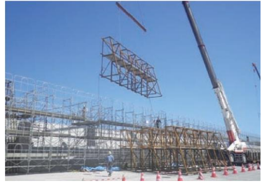
2. 鉄筋架台の設置
