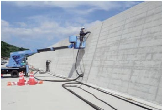
1. 既設部分の目荒らし
