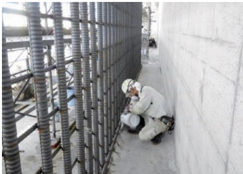
5. 主筋定着部の固定
