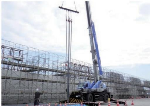
3. 新設部分の主筋建込み
