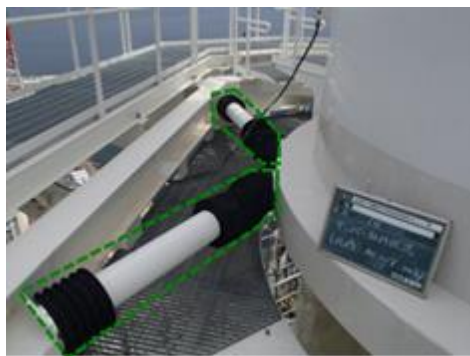
図 5-1 島根 2 号機の排気筒に設置した単軸粘性ダンパの外観及び構造
