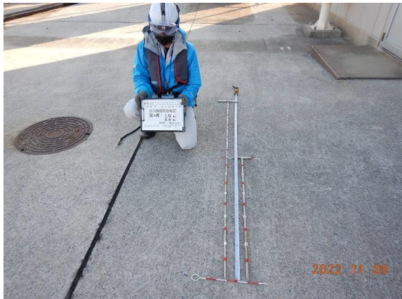
(a) 使用鉄筋棒全景
