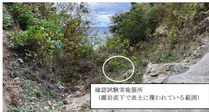
図 2-14 確認試験実施箇所拡大写真
