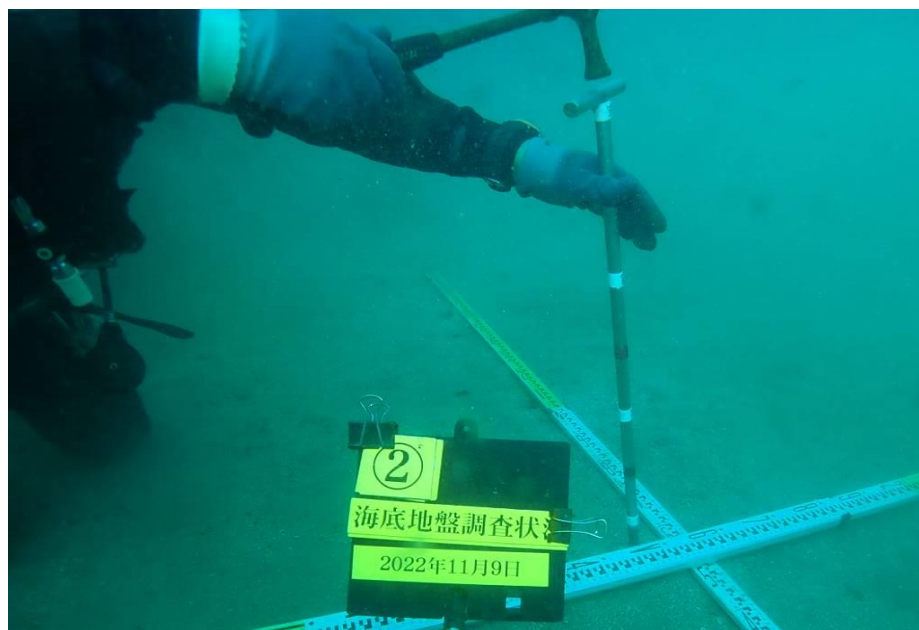
図 2-12 鉄筋棒貫入状況 (ハンマー使用) (参考) 19-11
