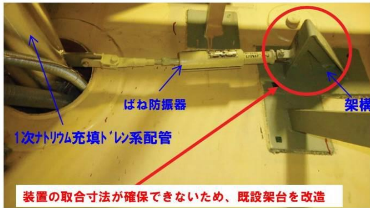
ばね防振器からメカニカル防振器への交換の例①
