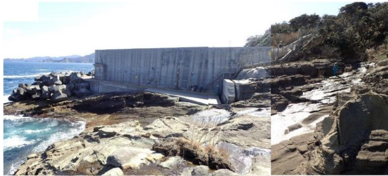
図 1.2-15 防波壁（西端部）地山状況
