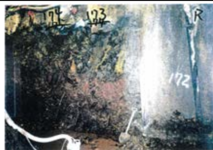
側壁(下半北側)No.174~173 写真
