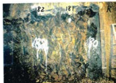
側壁(下半北側)No.181~182 写真
