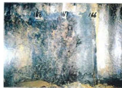
側壁(下半北側)No.166~168 写真
