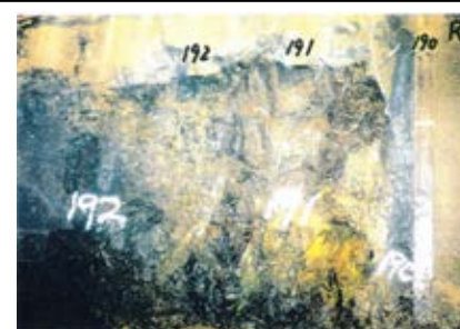
側壁(下半北側)No.190~192 写真
