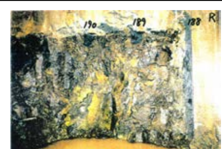
側壁(下半北側)No.188~190 写真
