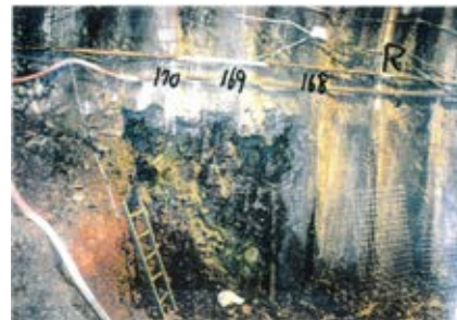
側壁(下半北側)No.168~170 写真
