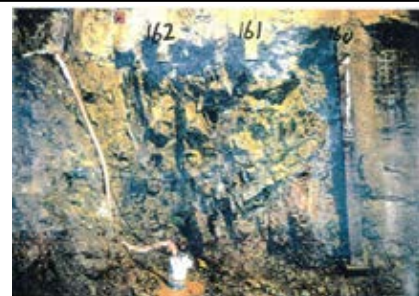
側壁(下半北側)No.160~162 写真
