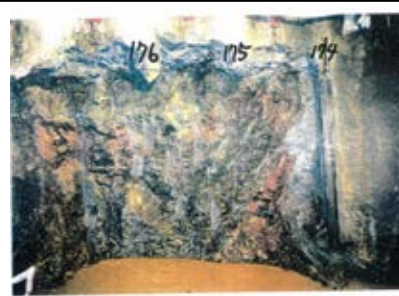
側壁(下半北側)No.174~176 写真
