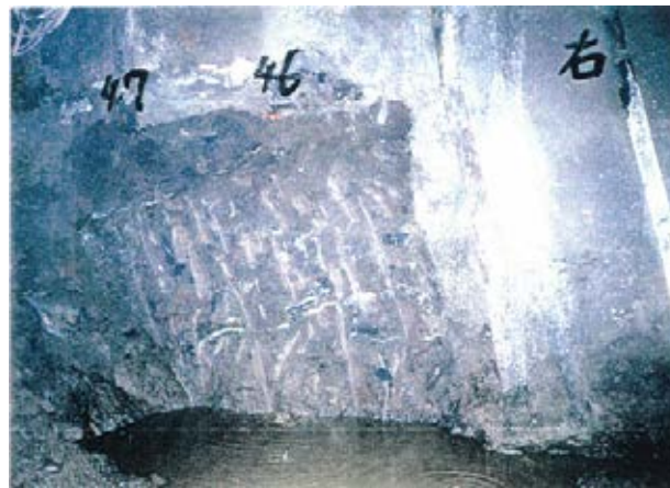
側壁(下半北側)No.46, 47 写真
