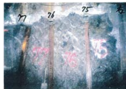
側壁(下半北側)No.75~77 写真
