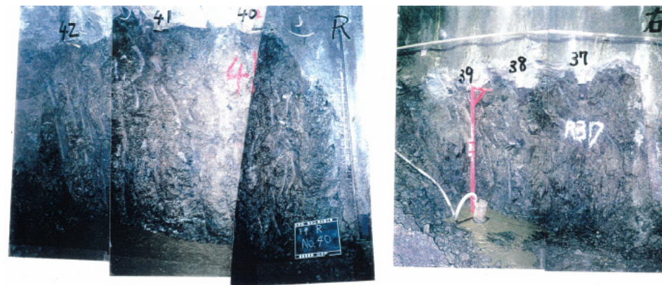
側壁(下半北側)No.35~36 写真なし No.37~42 写真
