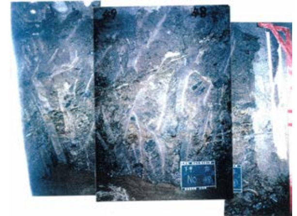
側壁(下半北側)No.48~49 写真 No.50~52 写真なし
