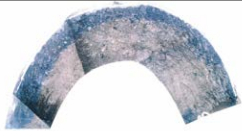
側壁(上半)No.74 写真
