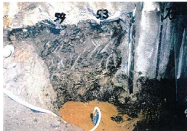
側壁(下半北側)No.53~54 写真
