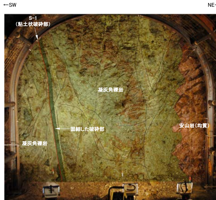
No.29切羽写真(割れ目等を加筆)
