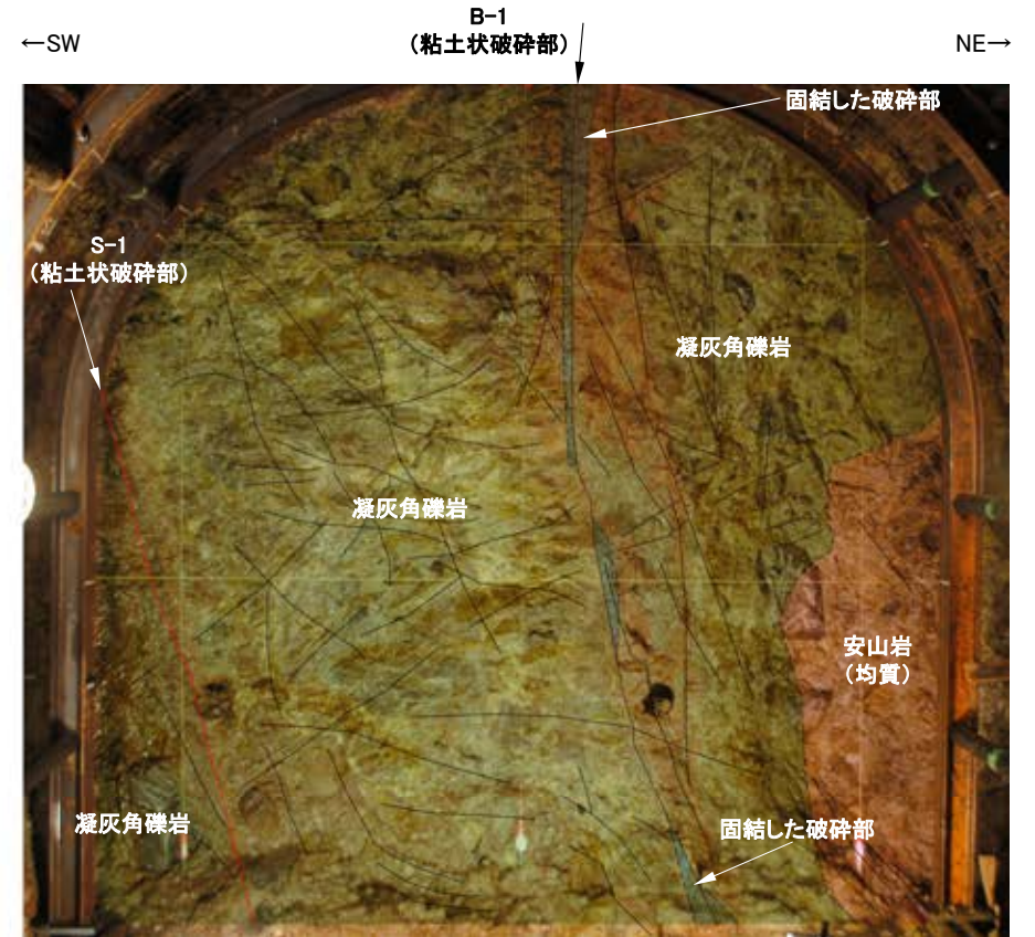
No.15切羽写真(割れ目等を加筆)
