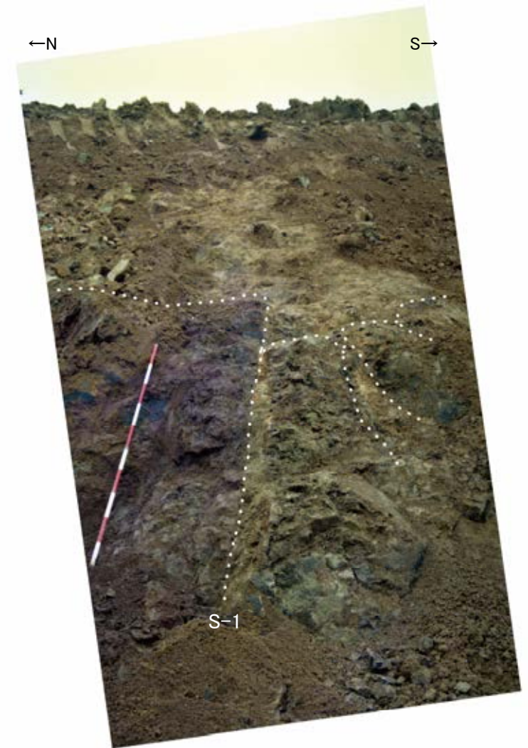
掘削法面 近接写真 (岩盤上面, 割れ目, S-1を白点で加筆)
