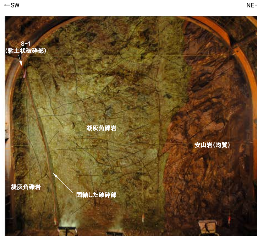
No.27切羽写真(割れ目等を加筆)
