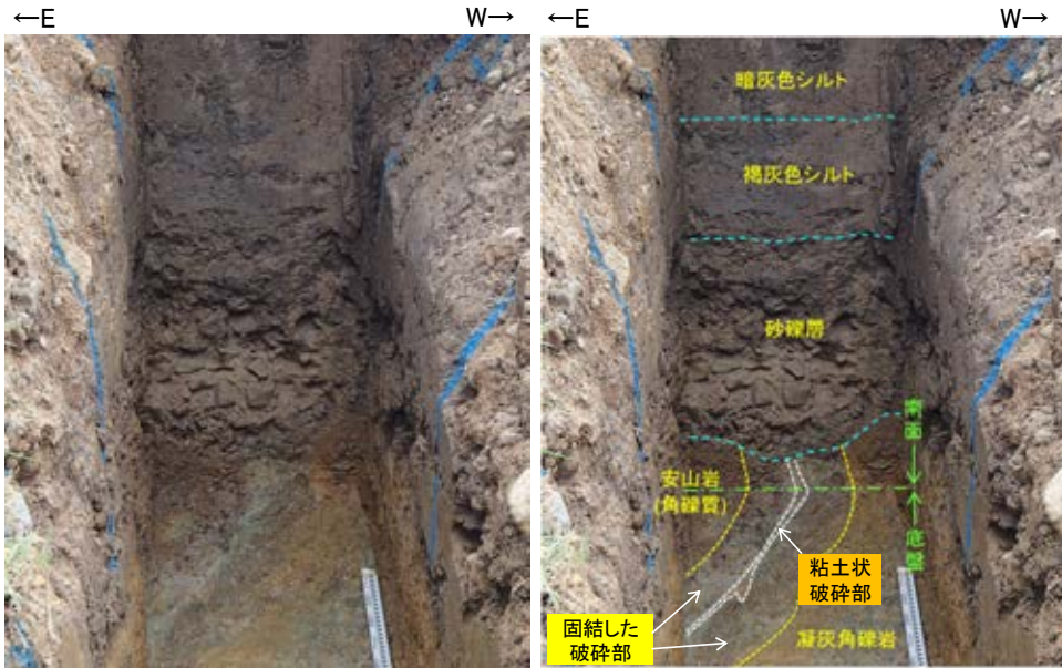
南面 拡大写真
