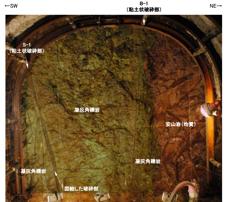
No.26切羽写真(割れ目等を加筆)
