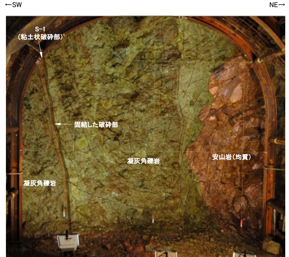
No.28切羽写真(割れ目等を加筆)
