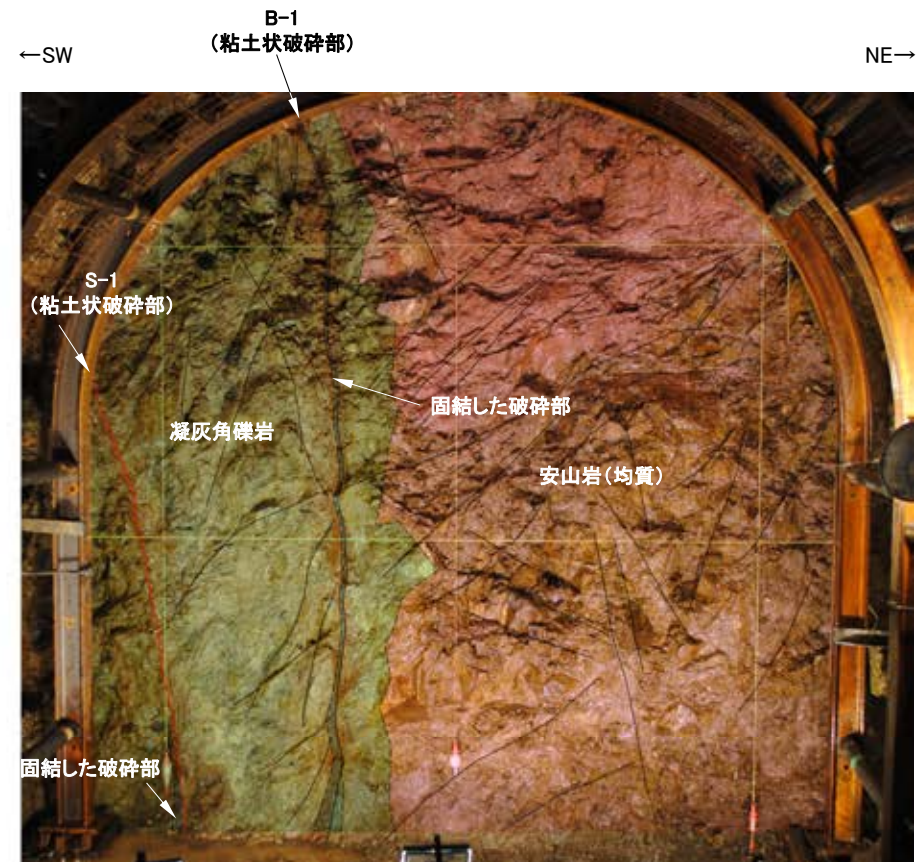
No.5切羽写真(割れ目等を加筆)
