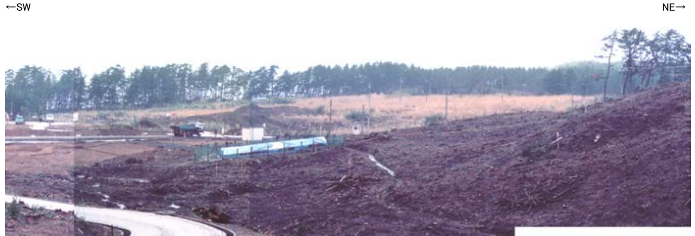
建設時写真(樹木伐採後)
