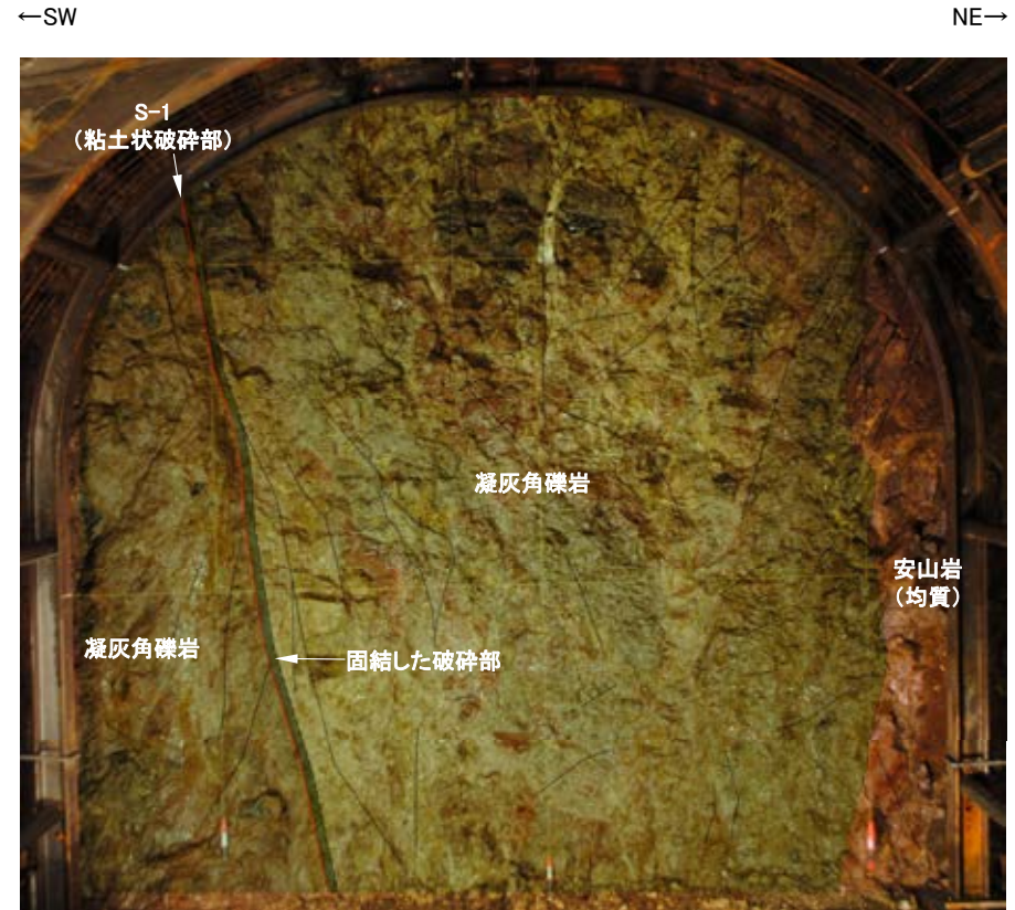
No.30切羽写真(割れ目等を加筆)
