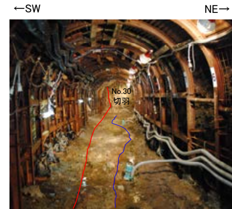
横坑の状況写真 (立坑側より, 2013年撮影)
