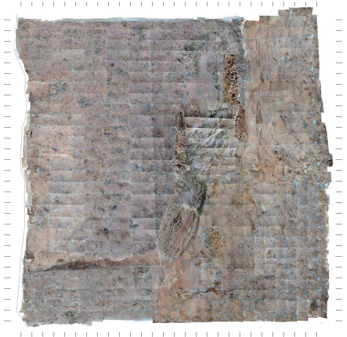
代替所内電気設備建屋 基礎地盤写真
