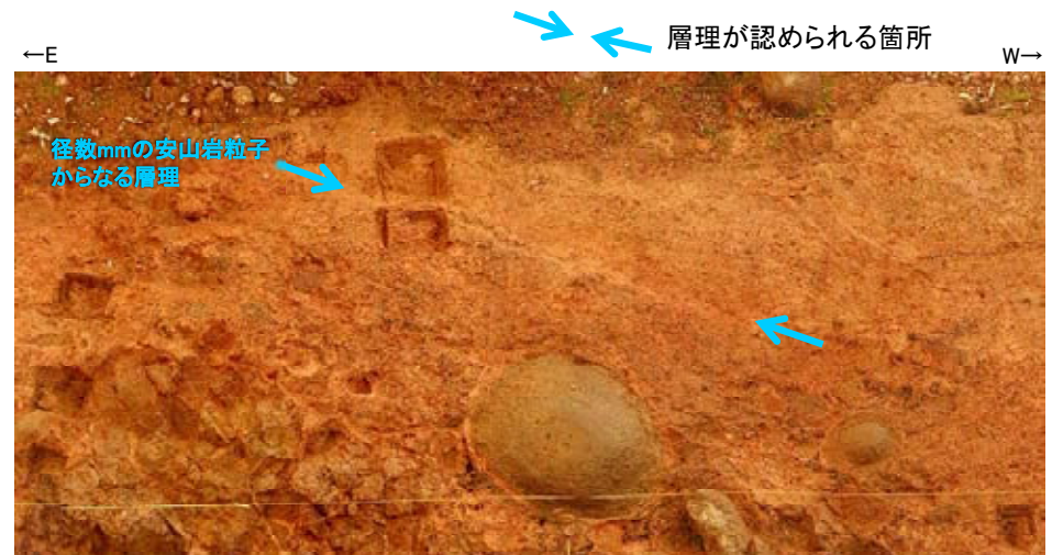
拡大写真(D) 層理が認められる
