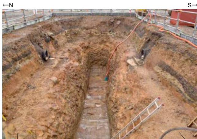
小段 トレンチ状況写真(西側から撮影) 小段
