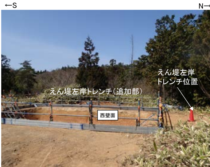
トレンチ状況写真(東側から撮影)
