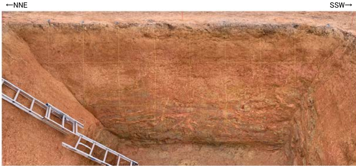
トレンチ写真(東壁面)
