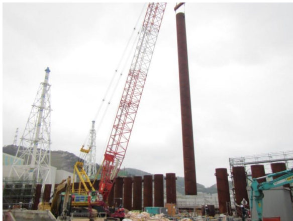
図 2.2-10 鋼管杭（中杭）の建て込み状況
