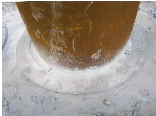
多重鋼管杭建込み状況 (モルタル(充填材)打設後) 図 1-3(2) 杭頭部の状況
