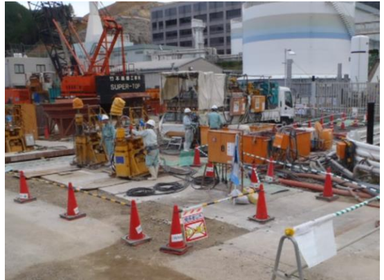
図 2.2-9 施工状況（左側：セメントミルク打設，右側：グラウト材注入）
