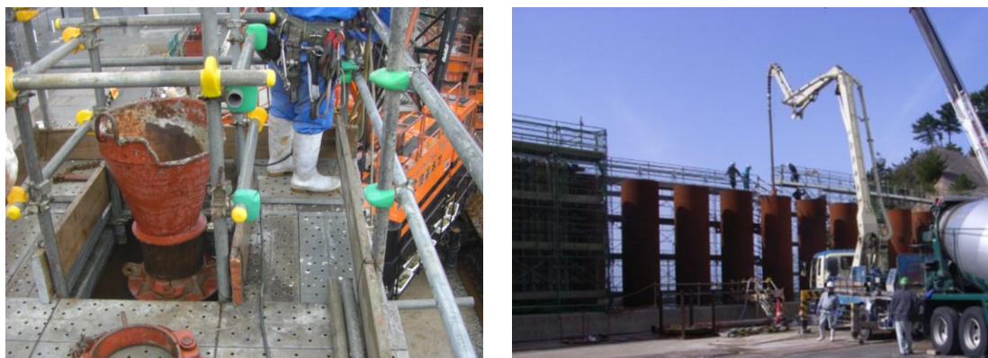
図 2.2-12 中詰コンクリートの施工状況
