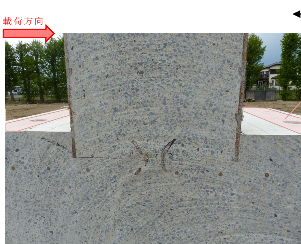
図 2.3.2-5 杭頭内部のひび割れ状況
