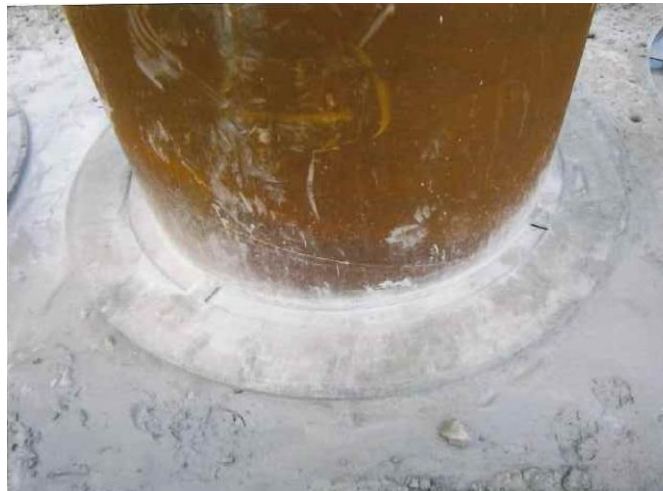
図 2.1-2(1) 杭頭部の状況
