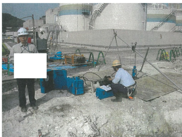
図7-2 引抜き試験実施状況写真 (2011年実施)
