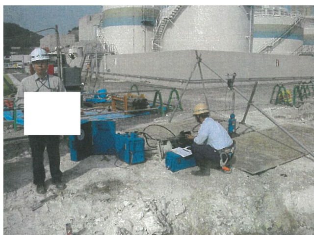
図7-2 引抜き試験実施状況写真 (2011年実施)
