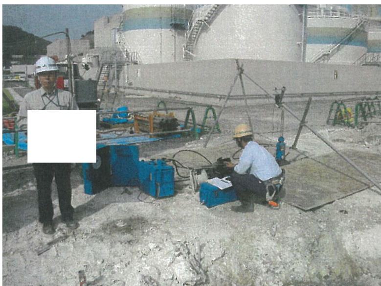
図 3-7 引抜き試験実施状況写真 (2011 年実施)
