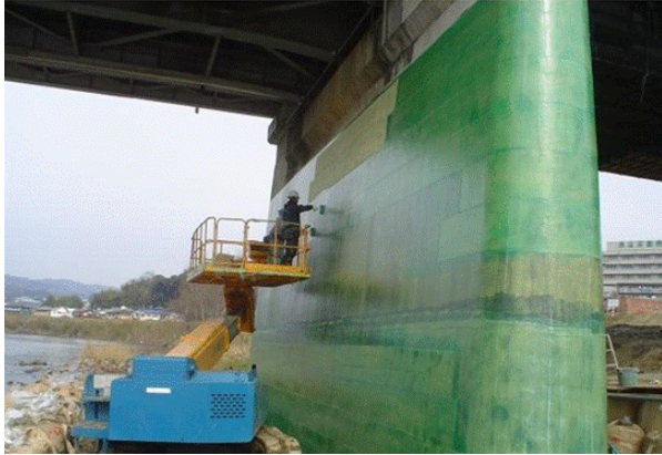
(a) 橋脚補強
