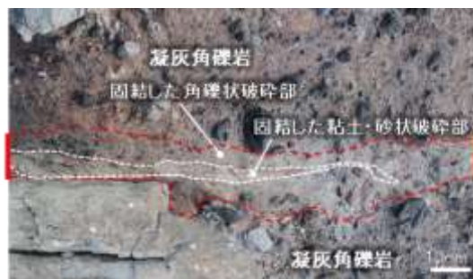
露頭における破碎部の事例
