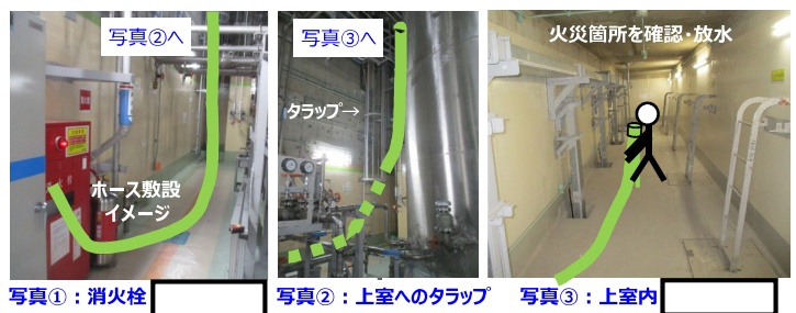
図4：冷却材脱塩塔室近傍の消火器及び消火栓の配置図
