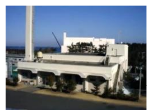
第1廃棄物処理棟
