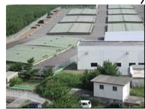
保管廃棄施設・L
