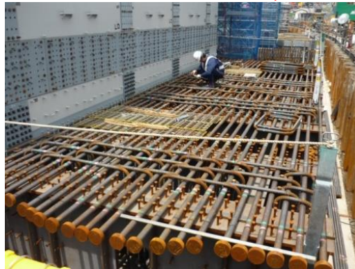
フーチング組立状況
