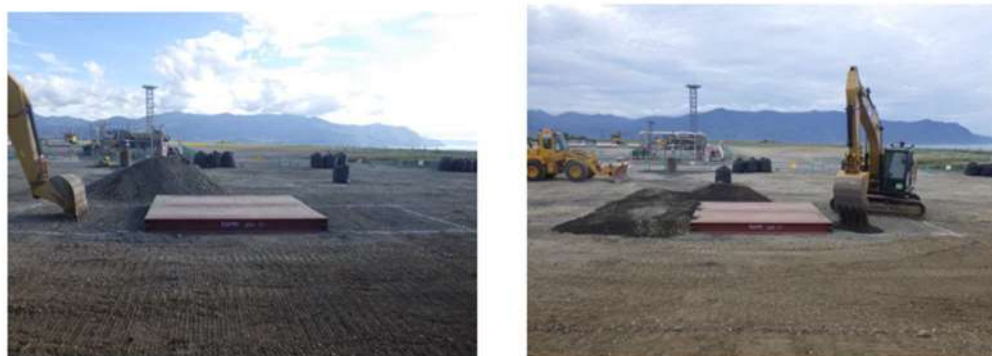
第10図 段差復旧状況
