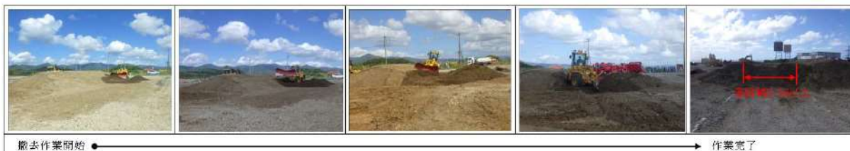
第5図 土砂撤去状況写真
