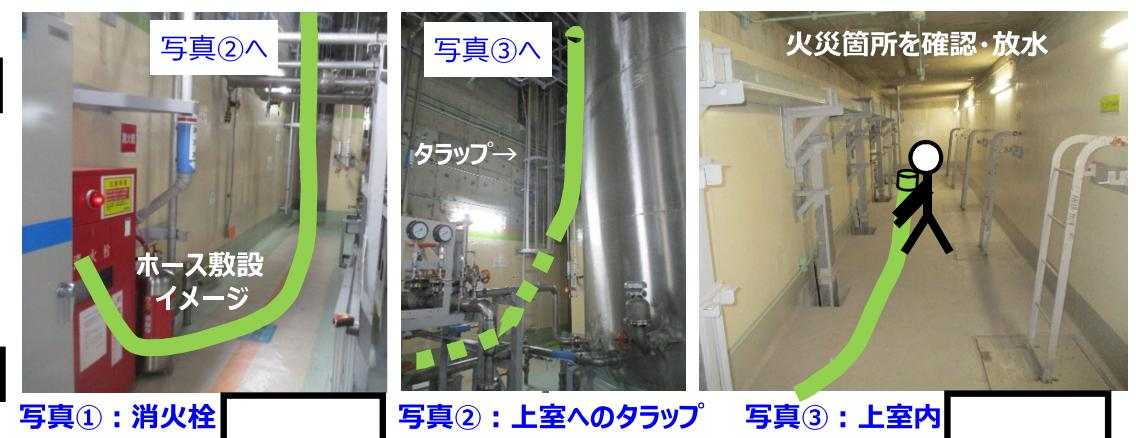
図11：冷却材脱塩塔室近傍の消火器及び消火栓の配置図
