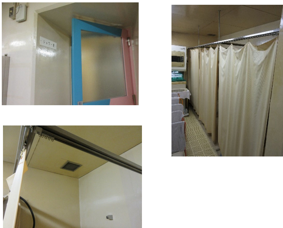
第 3-9-2 図 シャワー室の現場状況
