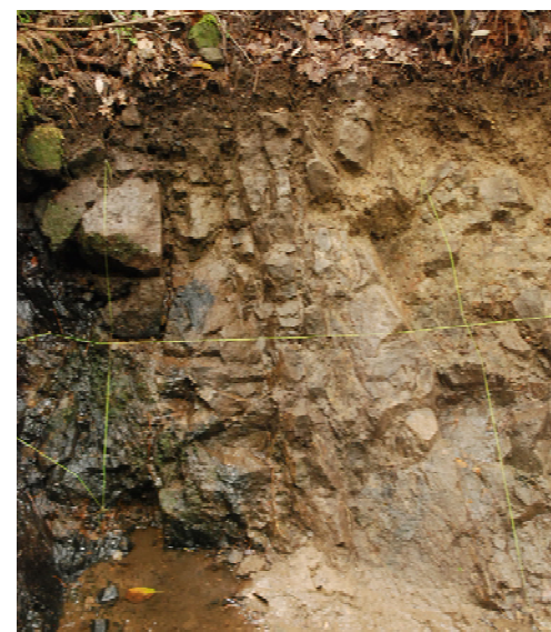
写真② 安山岩(均質)に発達する板状割れ目 (上:割れ目を加筆, 下:加筆なし)
