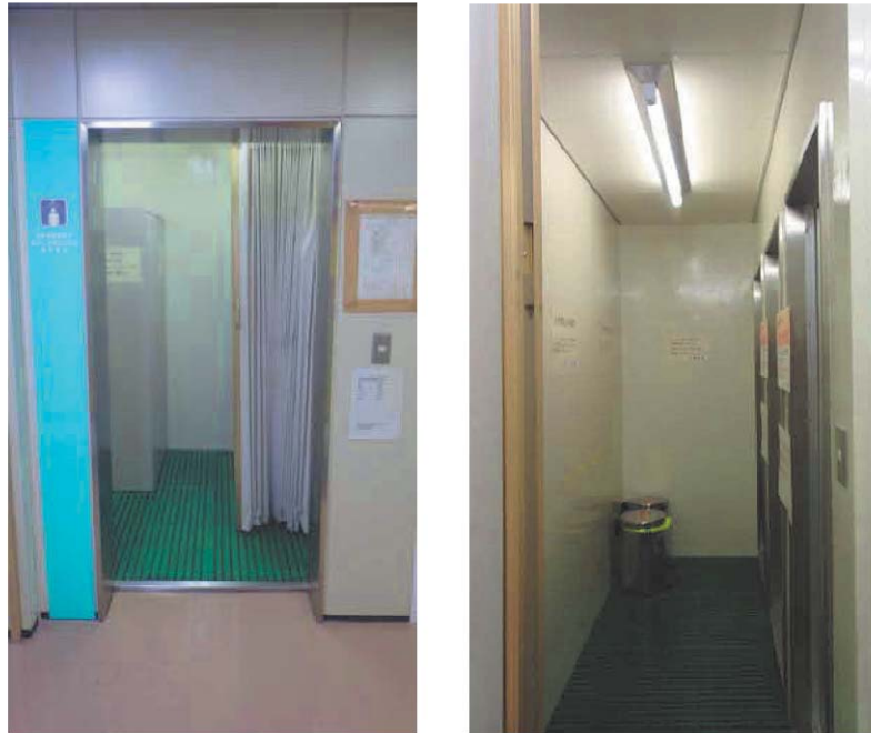
図7-5-2-6 ホットシャワー室（入口）及びシャワーボックス前通路の写真
