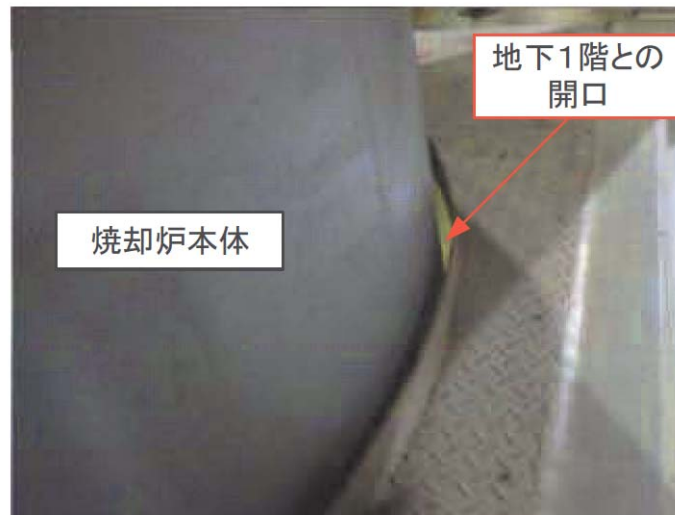
図7-6-1-2 地下1階フロアー地上1階フロアの開口
