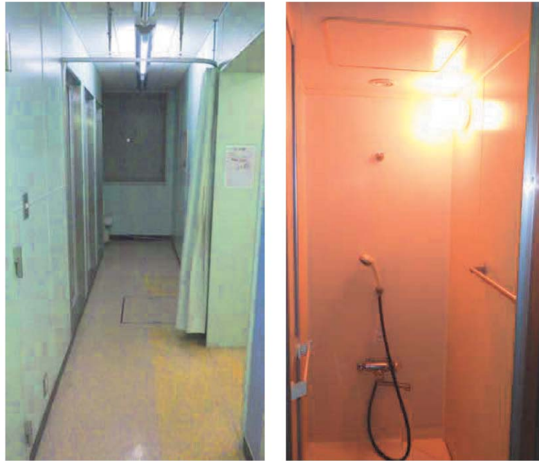
図7-5-2-2 コールドシャワー室及びシャワーボックスの写真
